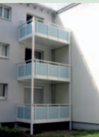
Mümlingstr. 4: Balkonanbau, neue Fassade
