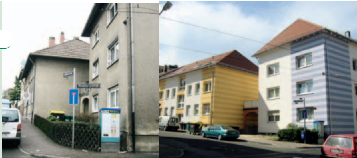
Schafheckstr. 2/Offenbacher Landstr. 414, vor und nach der Modernisierung.
