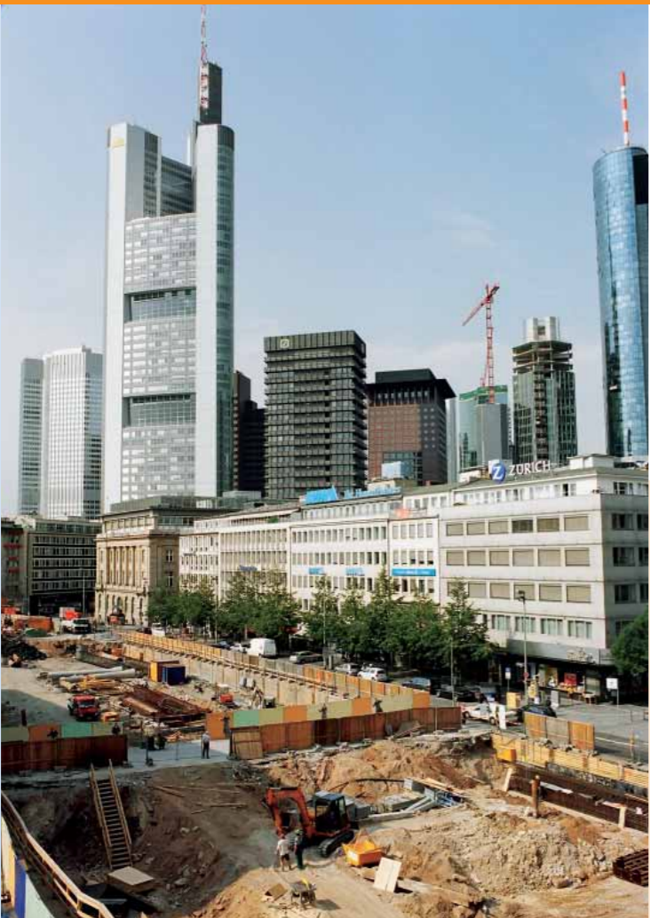
Die „Deckelbauweise“ hält Verkehrsbehinderungen so gering wie möglich.
