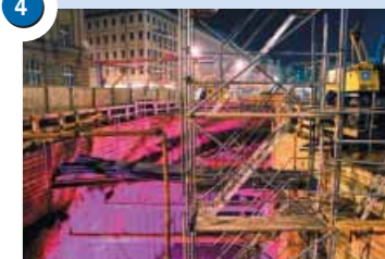
Parkhaus Goetheplatz: Bauarbeiten in vollem Gange
