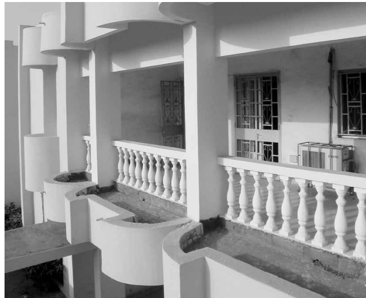
Außenansicht: Freundlich und einladend präsentiert sich das Forschungszentrum »Point Sud – lokales Wissen« in Bamako, Mali; es wird von der Gesellschaft für technische Zusammenarbeit (GTZ) und der Universität Frankfurt finanziell gefördert
