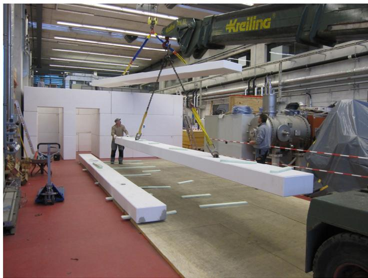
**Abbildung 1:** Errichtung der Betonabschirmung, Auflage der Deckenelemente mit einem Gewicht von 5,8t.
