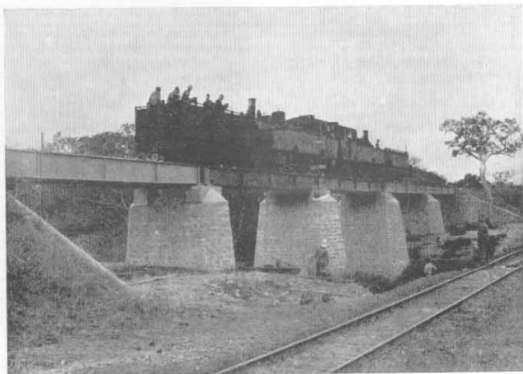
Abb. 99. Tanganjikabahn. Belastungsprobe von eisernen Überbauten.
