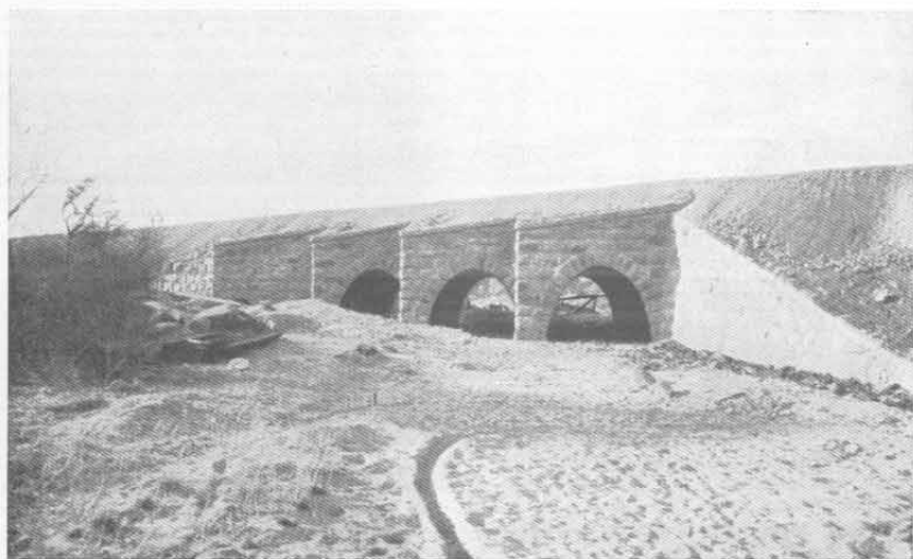
Abb. 109. Umbau Karibib—Windhuk. 3-gekuppelte schräge Durchlässe zwischen Okahandja und Waldau.
