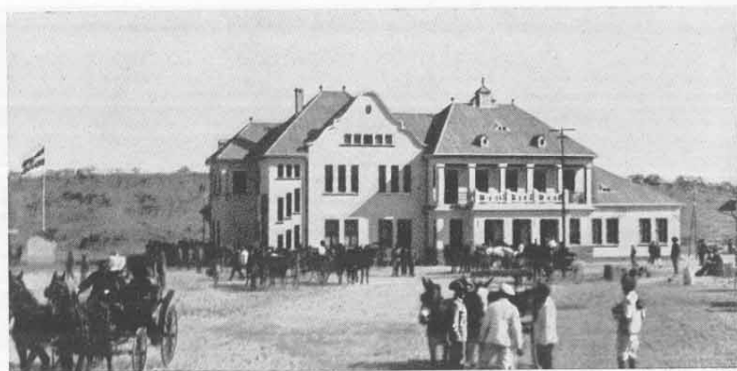
Abb. 121. Stationshaus auf Bahnhof Windhuk.
