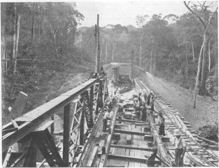
Abb. 97. Kam. Mittellandbahn. Lebnjokbrücke im Bau (Km 213) mit Umgebungsbahn.
