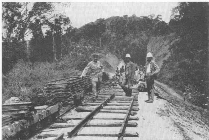
Abb. 91. Tanganjikabahn. Vorstrecken des Oberbaues.
