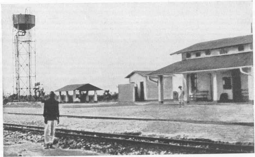
Abb. 126. Station Bahi, km 525, in der Grabensohle. Tanganyikabahn.
