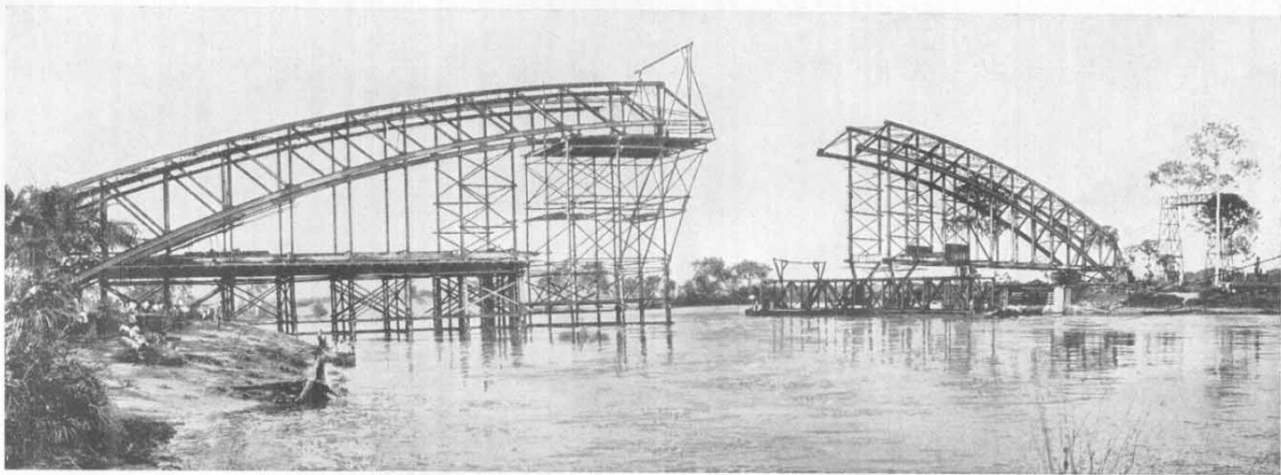
Abb. 103. Brücke über den Sanaga-Südarm. Einschwimmen des eisernen Überbaues.
