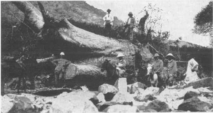
Abb. 87. Sprengen von Baum-Riesen mit Dynamit. Bahnbau Morogoro—Tabora.
