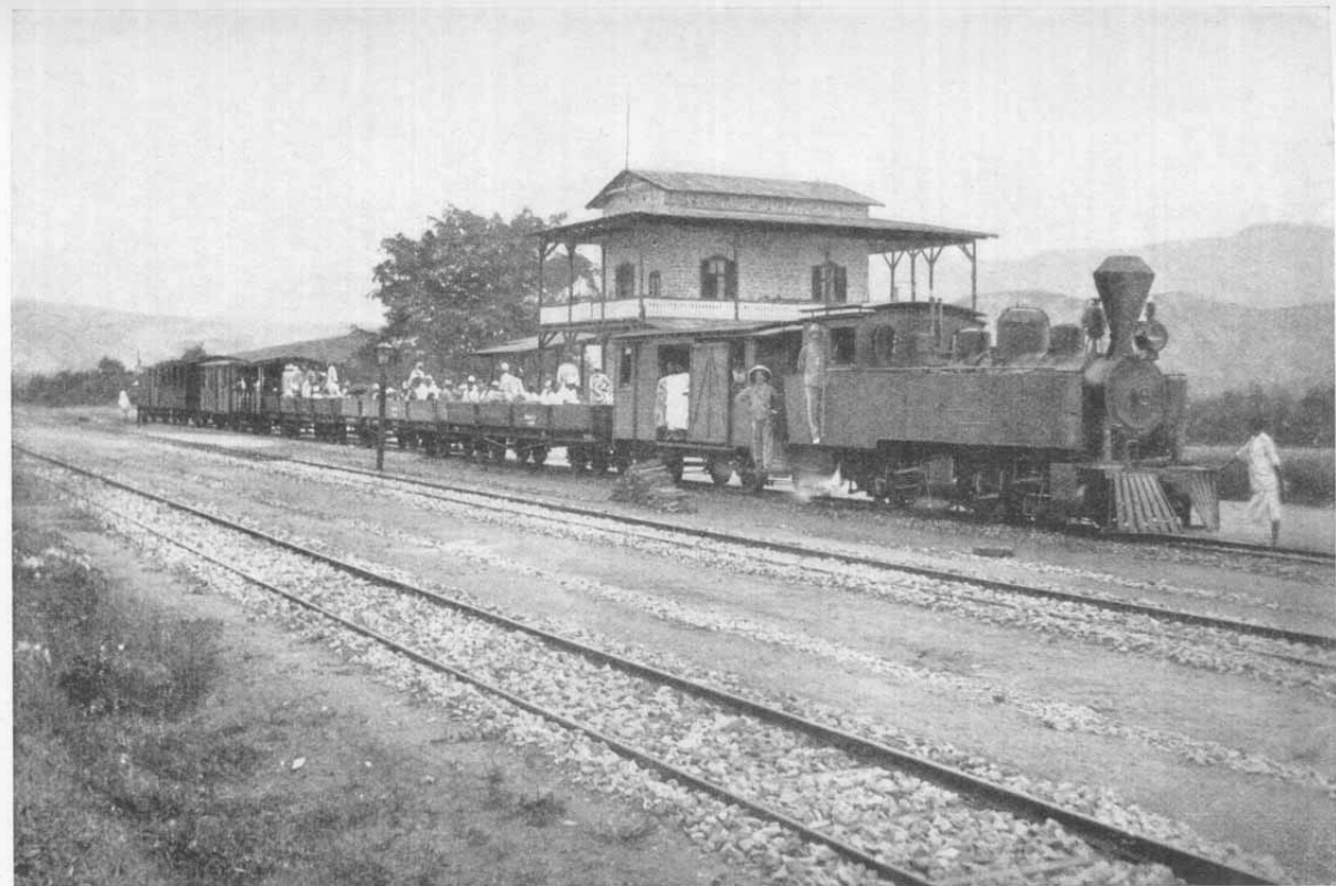
Abb. 12. Station Njussi der Usambarabahn.
