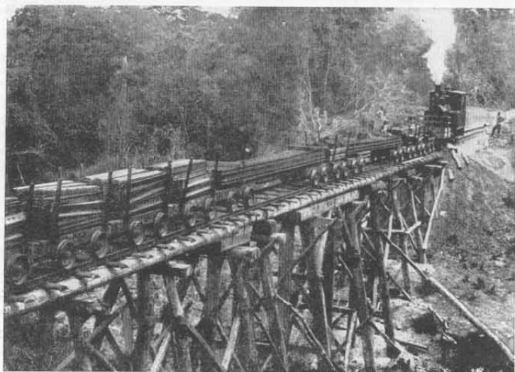
Abb. 90. Tanganjikabahn. Oberbauzug auf einer vorläufigen Holzbrücke.
