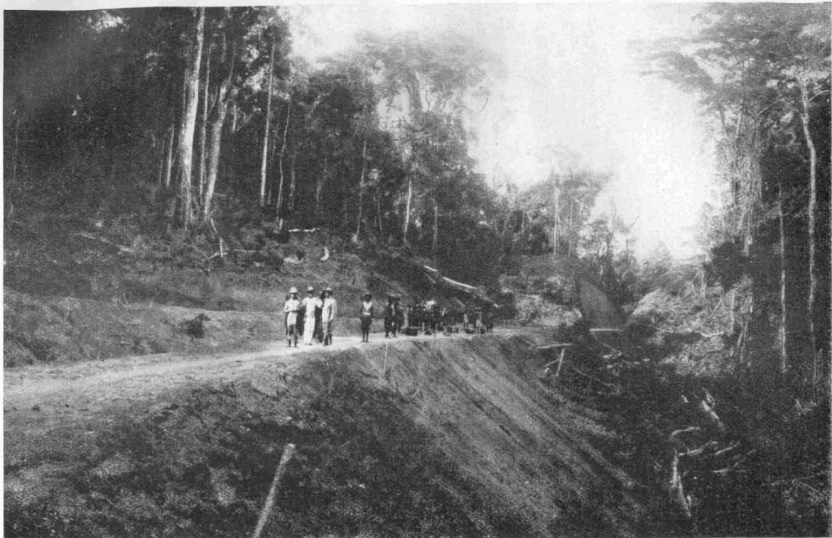
Erdarbeiten bei km 117—118.
