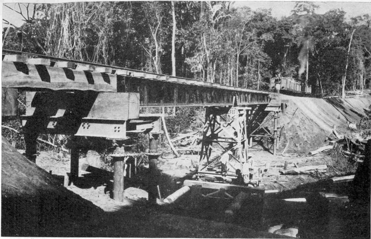
Brücke bei km 110.
