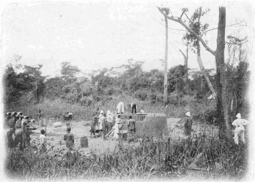
Bau eines Kalkofens in Stanleyville.
