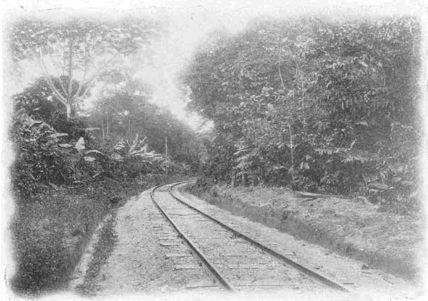
Ansicht der Bahn bei km 8.
