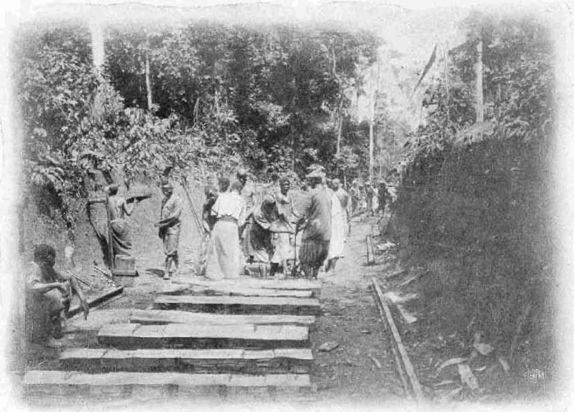
Legen und Bohren der Schwellen.
