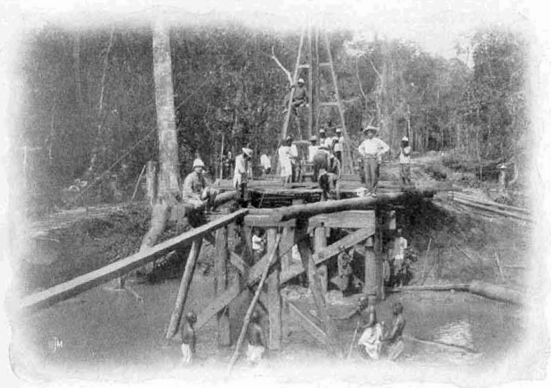
Pfahlgerüst der Uluko-Brücke (km 71).
