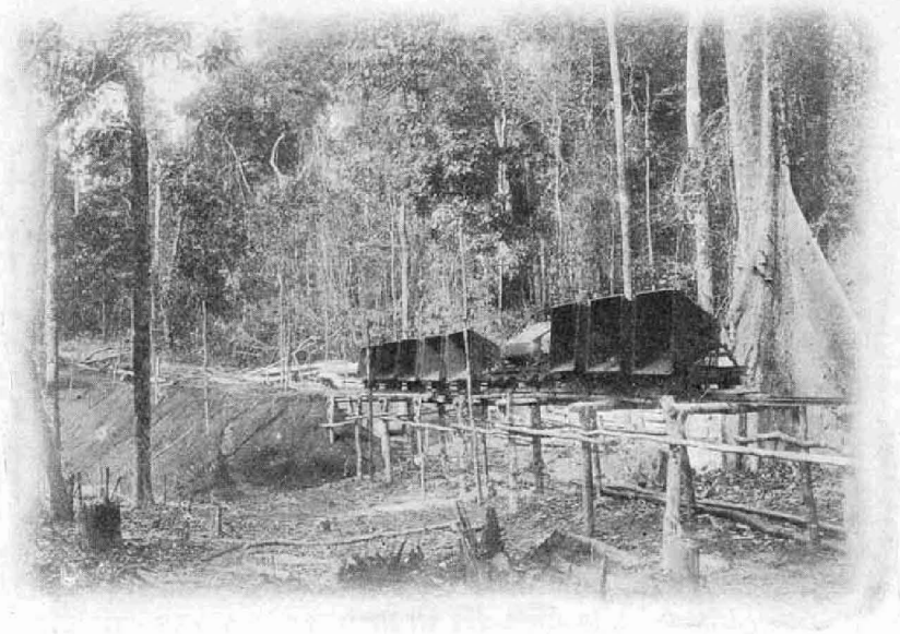
Dammbau bei km 77.
