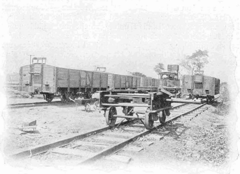
Eine Ecke des Bahnhofes in Stanleyville.
