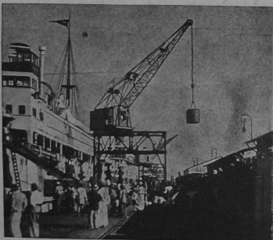
7 Vollportaldrehkrane für Stückgutbetrieb, 5 t Tragfähigkeit, 13,5 m Ausladung Hafenverwaltung Lourenco Marquez (Port. Ostafrika)
