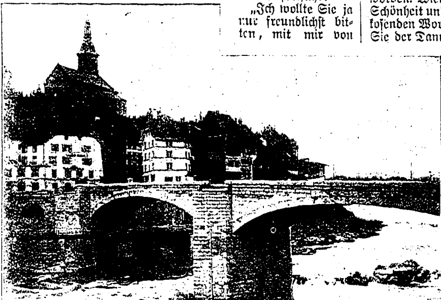
Die Rheinschnellen bei Lausenburg und die neue Brücke nach der Sprengung. (Mit Text.) Leipziger Presse-Büro, phot.
