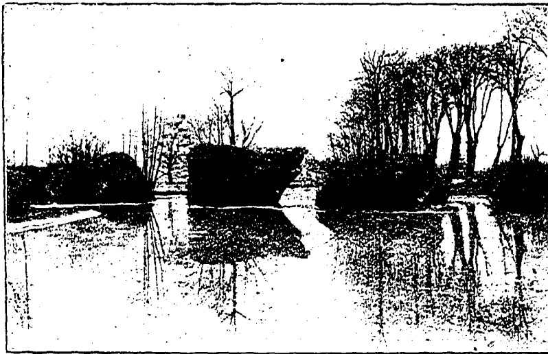
Die Reste der nach dem Abzug der Franzosen nach der Schlacht bei Vauban zerstörten Brücke, deren Trümmer heute noch stehen. (Mit Text.)
