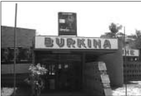
Vue du Ciné Burkina en pleine rénovation
