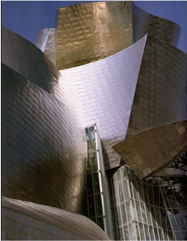
Abb. 23: Detailansicht auf die Dachkonstruktion, Blick von Norden
