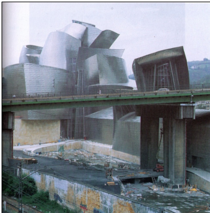
Abb. 22: Blick von Osten auf die Museumsbaustelle
