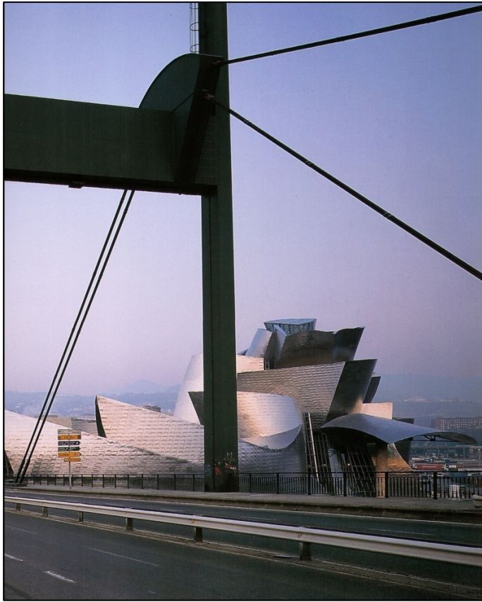
Abb. 20: Blick von der Brücke aus Richtung Norden
