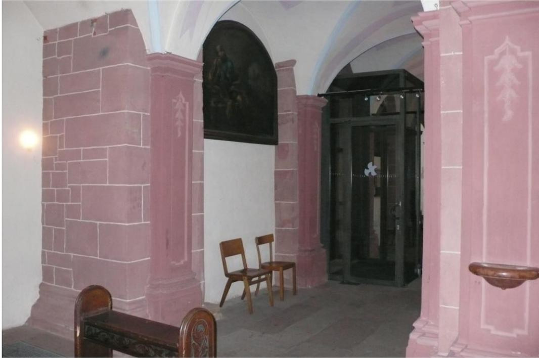
**Abb. 42:** Blick aus dem südlichen Seitenschiff unmittelbar vor der Westwand nach Nordwesten. Die barocken Pilaster tragen die Orgelempore. Das Quadermauerwerk markiert den Vorsprung der Vorhalle in das Mittelschiff.
