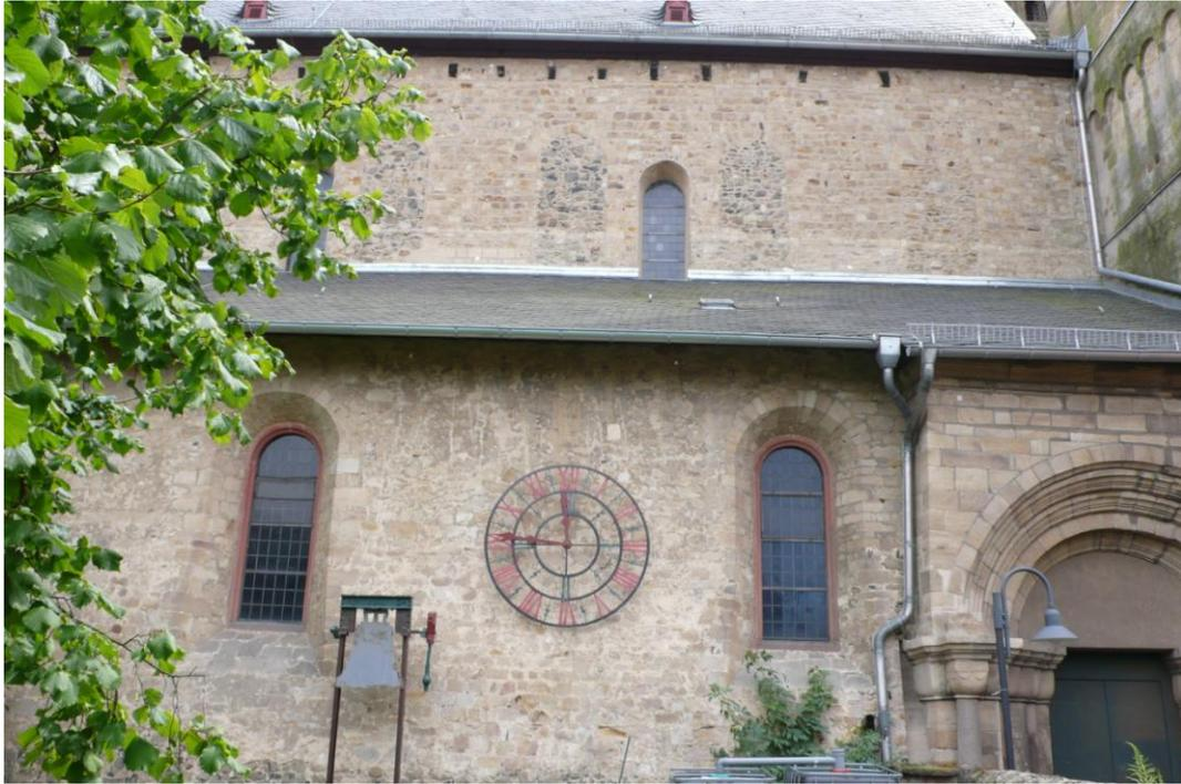
**Abb. 18:** Die Nordseite mit Seitenschiff und Obergaden. Rechts das Nordportal. Im Obergaden sind die vermauerten Fenster noch gut sichtbar (vgl. Abb. 10).
