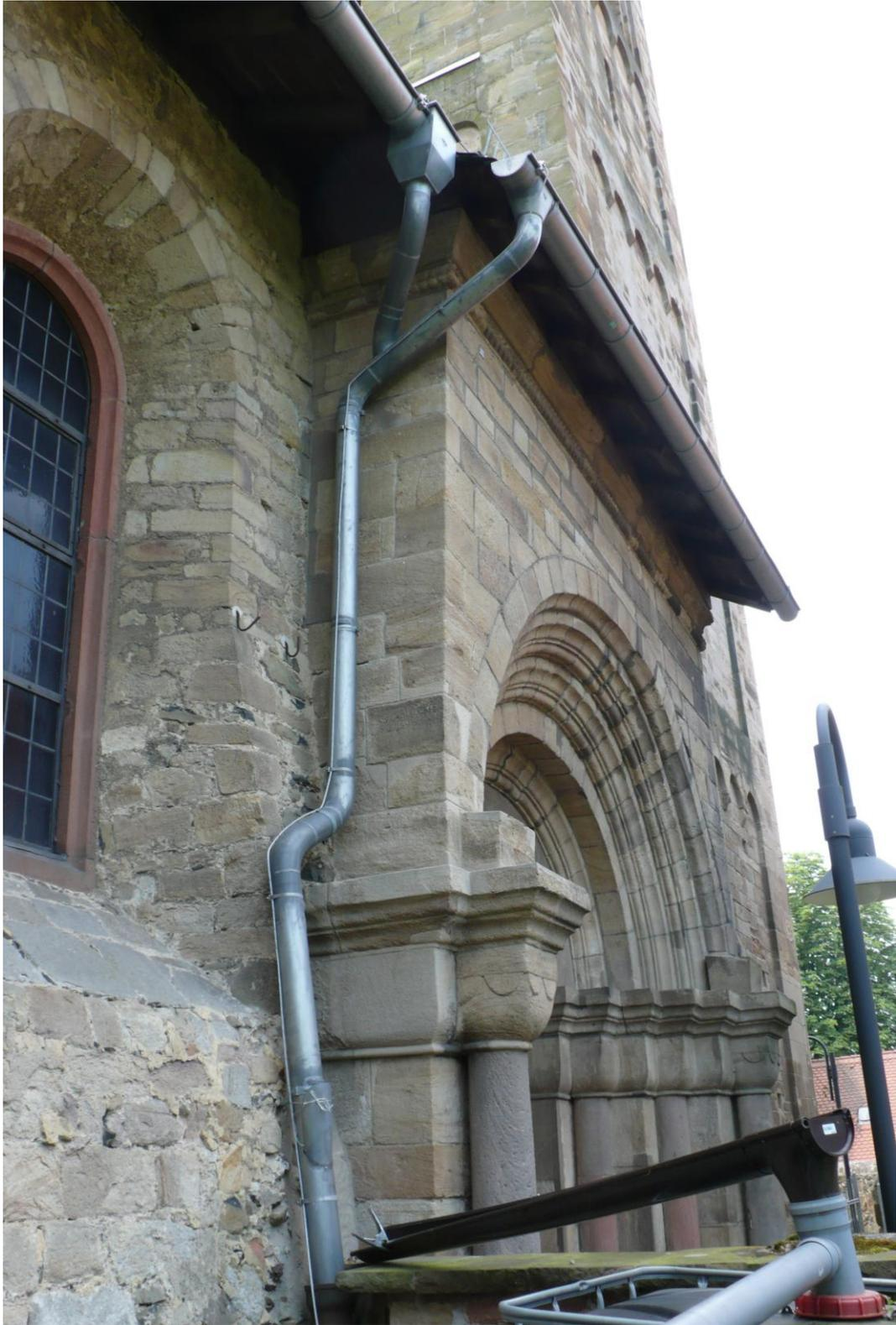
**Abb. 17:** Das Nordportal nach Südwesten gesehen. Im Bildhintergrund der Nordturm, im Mittelgrund das Portal. Auf den Abakusplatten der Freisäulen sitzt jeweils ein Segmentbogenstein, der zwei geplante Bögen nach Norden, und damit eine Hallenkonstruktion vermuten lässt. Im Vordergrund die schräg anlaufende, im 17. Jahrhundert erneuerte Seitenschiffsmauer.
