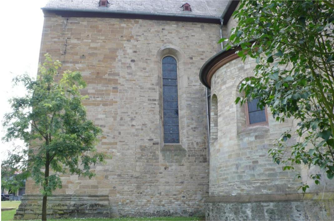
**Abb. 21:** Die Nordwand des Chores und der Apsis. Rechts die schräg anlaufende Nordquerhaus-Apside. Am Chor und der Hauptapsis ist mittig die senkrechte Baunaht auf den ersten Blick zu erkennen. Der Eindruck eines angebauten Baukörpers wird durch den Sockel an der Apsis verstärkt.
