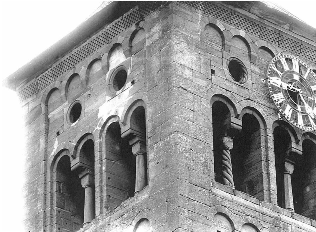
**Abb 5:** Das Obergeschoss des Nordturmes während der Restaurierungskampagne von Nordwesten aus gesehen. Der Schachbrettfries, die gedrehte und die achteckige Säule sind gut zu erkennen.
