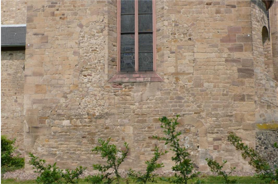
**Abb. 26:** Die untere Hälfte des Südquerhauses mit verschiedenen Befunden. In der rechten Hälfte ist eine vermauerte Tür zu erkennen, links und rechts des Fensters sind die beiden vermauerten romanischen Fenster zu sehen.
