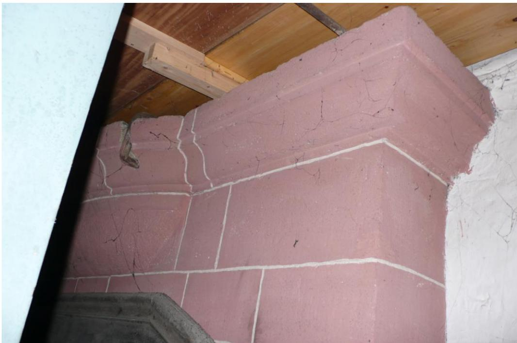
**Abb. 43:** Mauervorsprung der Vorhalle auf Höhe der Orgelempore von Nordosten aus gesehen. Der Block bildet das Podest für die auskragende Kapelle. Die Rundung in der linken Bildhälfte bildete das Auflager für die auskragende Apsis.
