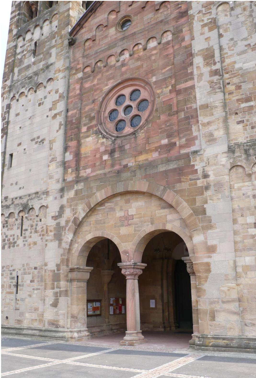
**Abb. 14:** Die Westvorhalle von Außen. Der 1871 erneuerte Mittelteil ist durch den roten Sandstein zu erkennen.
