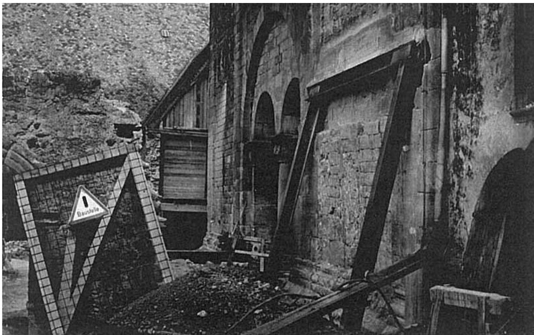
**Abb. 11a:** Die gleiche Stelle, nachdem der Strebepfeiler beseitigt wurde. Ganz links am Bildrand ist der Torbogen aus dem 17. Jahrhundert zu sehen, der heute in einer Gartenmauer auf der Nordseite steht. Die Verlängerung der Wand, in der er sich auf dem Bild noch befindet, ist nicht mit dem Turm verzahnt. Diese Beobachtungen machen ein romanisches Atrium äußerst unwahrscheinlich.
