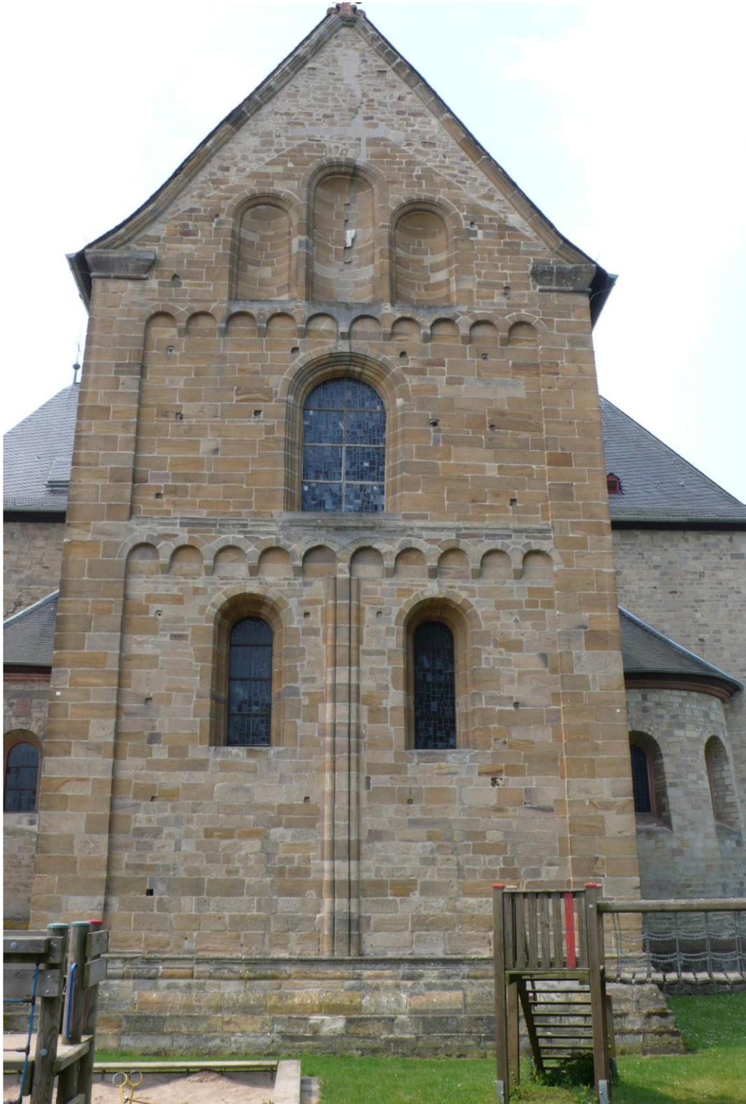
**Abb. 23:** Die Hauptapsis von Osten. Unter dem unteren Rundbogenfries enden die Begleitstäbe der Mittellisene ohne Anschluss, was für einen Planwechsel spricht, ebenso wie das obere mittlere Fenster, das mit der Lisene kollidiert. Am Giebel ist die frühneuzeitliche Dacherhöhung deutlich sichtbar.
