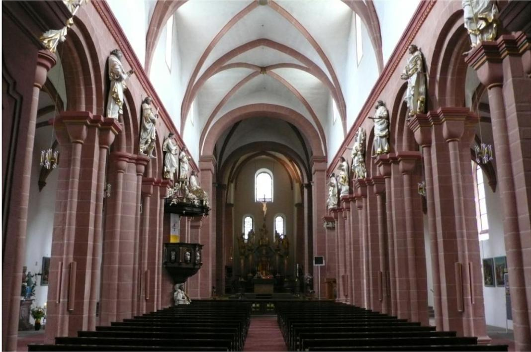
**Abb. 32:** Blick in das Langhaus nach Osten. Die unterschiedliche Pfeilerstellungen links und rechts und das nachträglich eingezogene, gotische Gewölbe sind gut zu erkennen.
