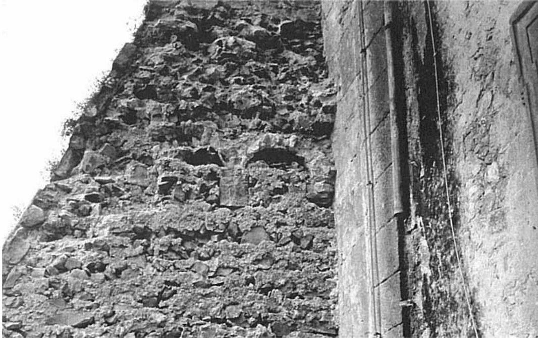
**Abb. 11:** Der Strebepfeiler vor dem Südturm während seines Abrisses. Im Mauerwerk sind die eineinhalb Bögen eines Rundbogenfrieses gut zu erkennen. Sie kamen zum Vorschein, nachdem eine vor der jetzt sichtbaren Fläche stehenden Wand abgerissen wurde. Diese Wand hat Untermann als Atriumsmauer identifiziert. Die profilierte Gebäudekante rechts im Bild gehört zu den an den Südturm anschließenden, barocken Konventsbauten.
