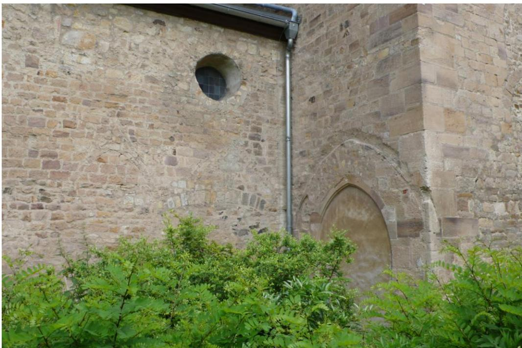
**Abb. 27:** Winkel, in dem das südliche Seitenschiff auf das Querschiff trifft, von Südwesten gesehen. Die spitzbogige Tür in der Westwand des Querschiffs ist gut zu erkennen, ebenso der Gewölbeansatz darüber. Weniger gut sind die zwei Gewölbejoche am Seitenschiff zu erkennen. Direkt am Winkel liegt im Seitenschiff der Segmentbogen, der wahrscheinlich ein *Arkesolgrab* aufnahm. Darüber einer der Okuli.
