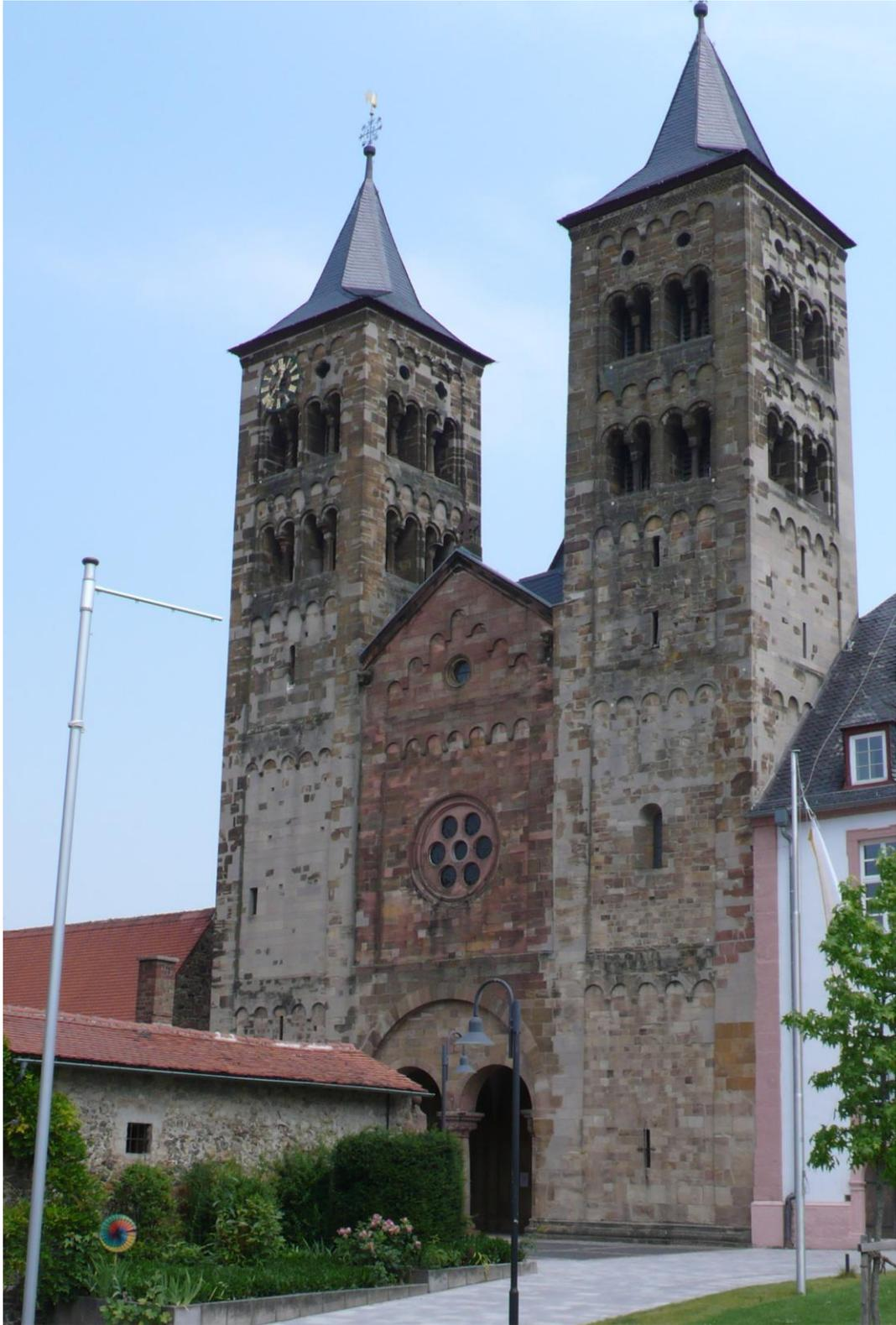
**Abb. 4:** Die Basilika von dem südwestlich gelegenen Vorplatz aus gesehen. Rechts schließen sich Konventsgebäude an. Deutlich erkennbar ist das unterschiedliche Baumaterial von Türmen und zwischenliegendem, 1871 rekonstruiertem Giebel.
