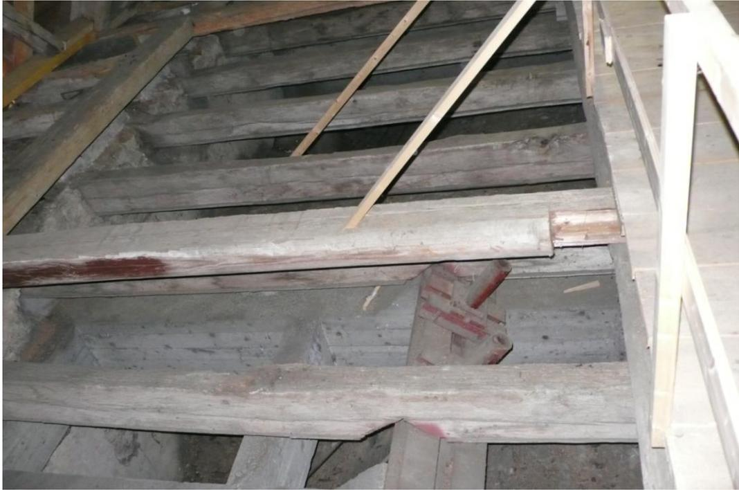
**Abb. 9:** Einige der 31 romanischen Deckenbalken, die sich noch immer *in situ* quer über den gotischen Gewölben befinden. Alle Balken zeigen eine Nut in Längsrichtung, in die kleine Bretter quer eingeschoben werden können, damit die Decke geschlossen ist.
