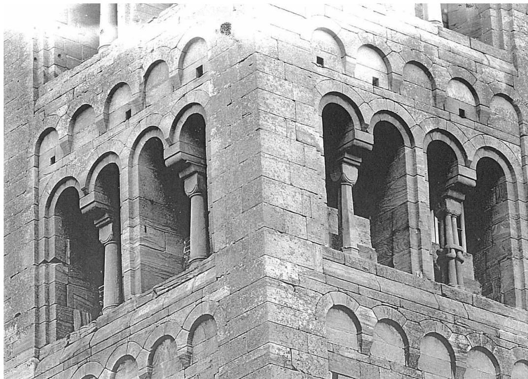
**Abb. 6:** Der gleiche Turm zur selben Zeit, ein Geschoss darunter. Rechts ist die Knotensäule zu sehen.
