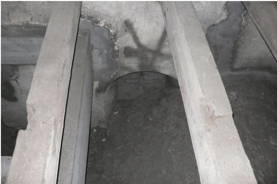
**Abb. 10:** Die Wand des nördlichen Obergadens vom Dachstuhl aus gesehen. Unter zwei der romanischen Deckenbalken sitzt eine Gewölbekappe, die ein romanisches vermauertes Fenster überschneidet. Die Vermauerung ist von außen erfolgt und vor die Fenstersprossen gesetzt worden. Deswegen sind die Fenstersprossen innen noch gut sichtbar und erhalten. Auf der Wandfläche befindet sich noch der romanische Putz, der bis an die Balkendecke reichte.
