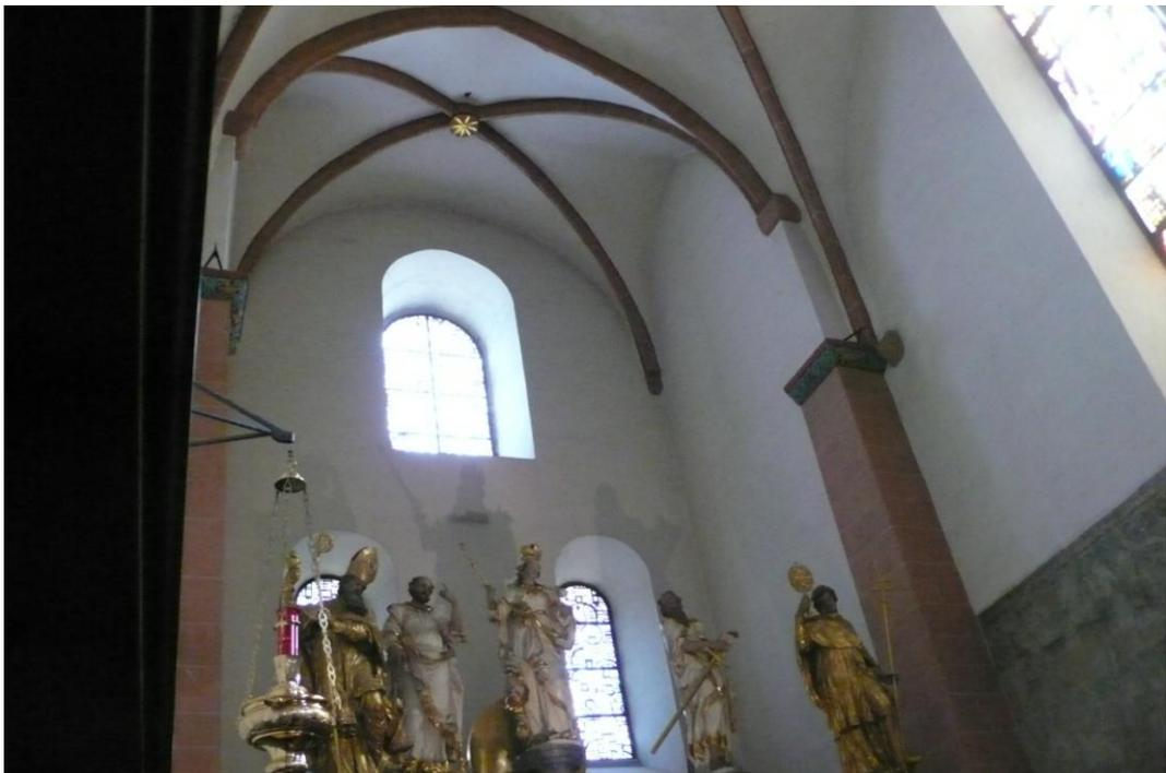
**Abb. 38:** Blick in den Chor und die Apsis. Die ehemaligen, eingezogenen Lisenen für den Bogen der ersten Apsis sind gut sichtbar. Das gotische Gewölbe sitzt ohne Vermittlung auf den romanischen Architekturgliedern auf.
