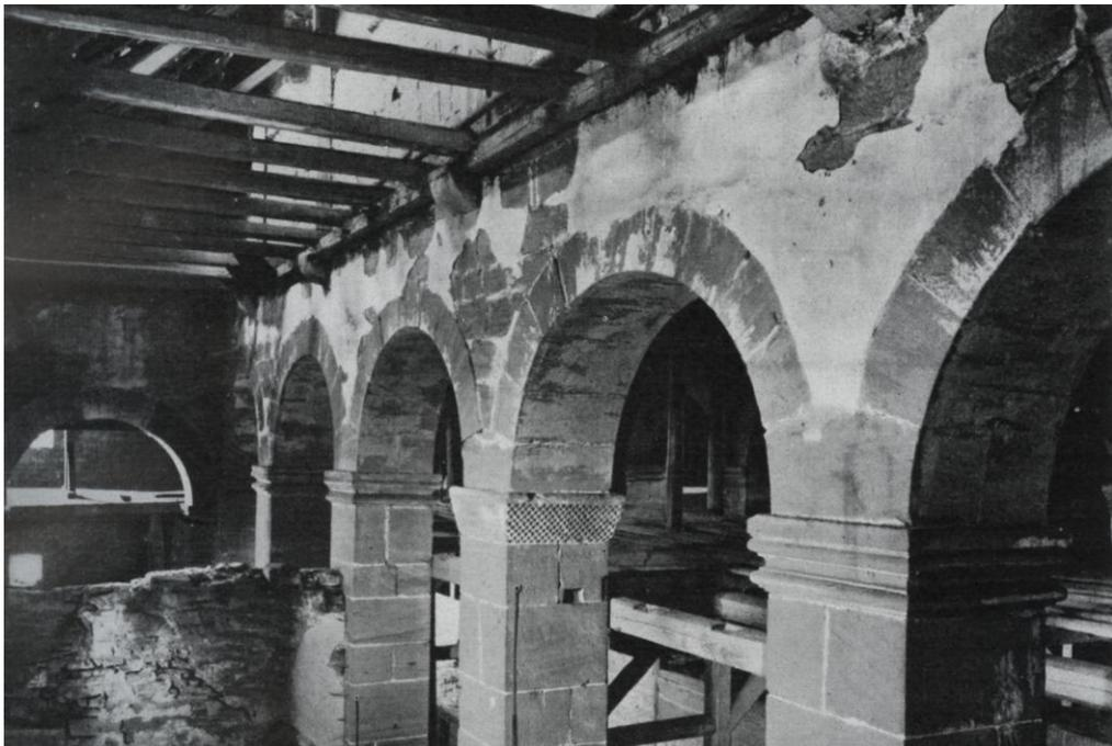
**Abb. 34:** Das Nordseitenschiff in Veßra mit Blick nach Osten und in das Hauptschiff vor dem Brand von 1939. Links unten sind die Reste des Lettners zu erkennen. Der erste Pfeiler nach dem Lettner ist mit einem Schachbrettfries ausgezeichnet, vgl. auch Abb. 53.
