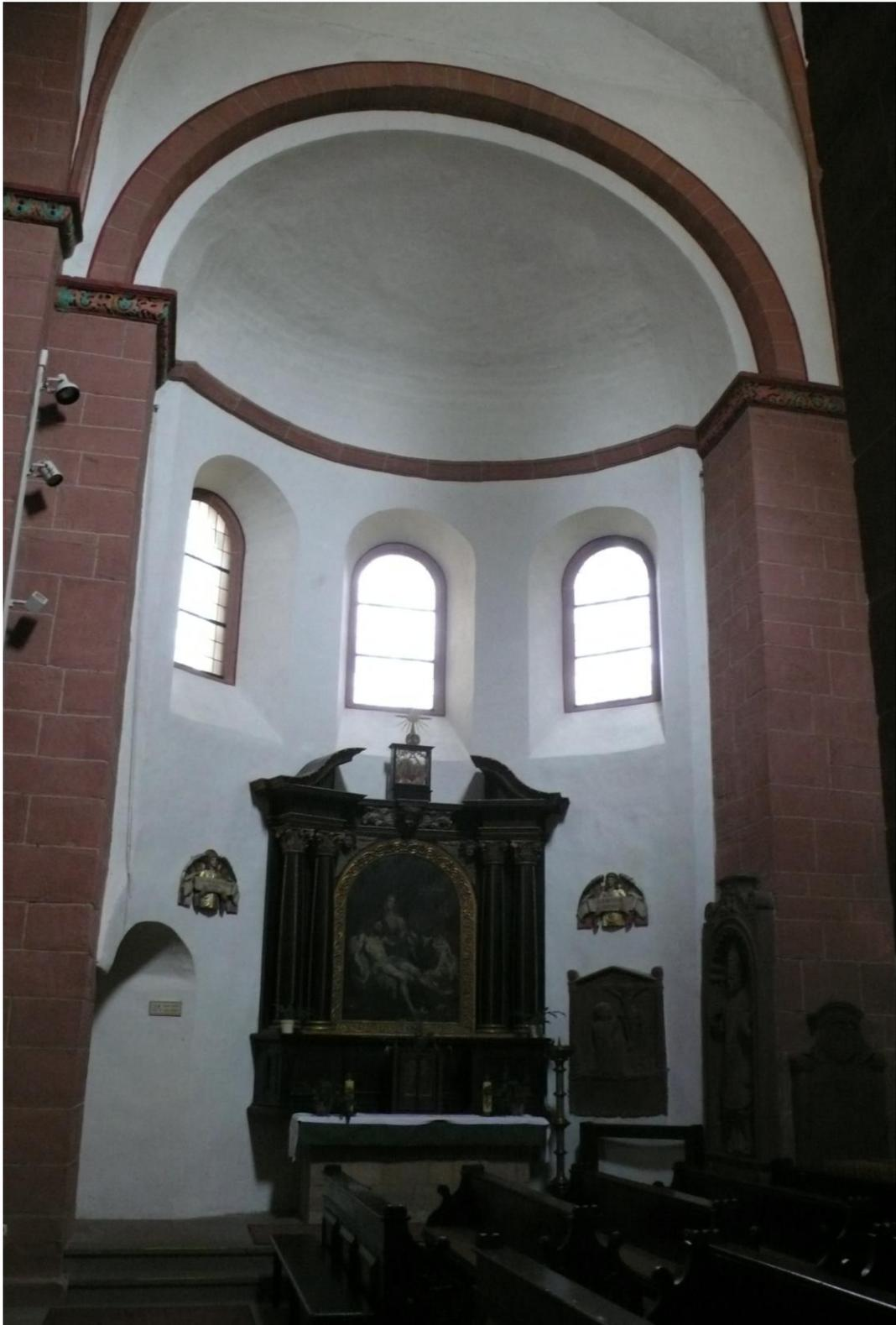
**Abb. 37:** Die südliche Seitenapside. In der linken Ecke sind die eingebrochenen Durchgänge in den Chor zu sehen
