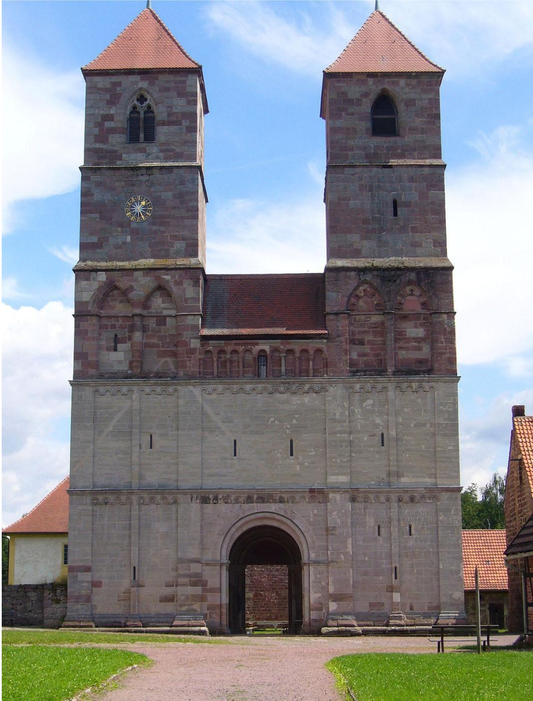
**Abb. 52:** Der Westbau in Veßra mit einer Doppelturmanlage und dazwischen liegender Vorhalle. Über der Vorhalle liegt ein weiterer Raum, ebenso im Südturm. Die Erschließung ist heute über den Nordturm geregelt. Wie die Räume im Einzelnen genutzt wurden, ist nicht klar, der mittlere Raum muss auch recht dunkel sein.
