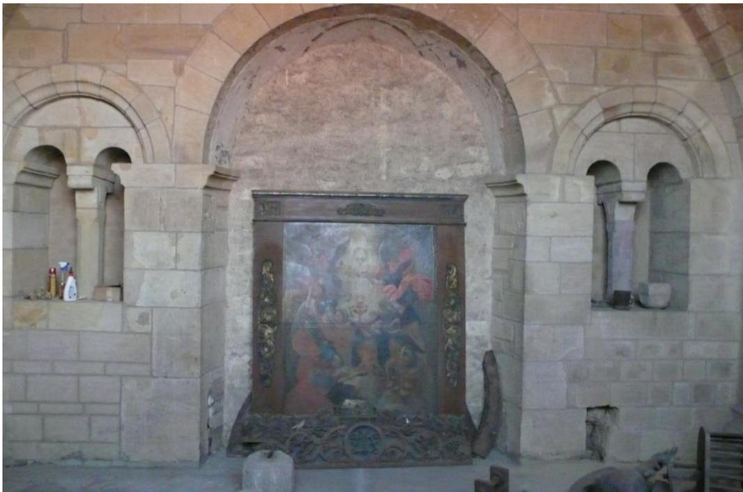
**Abb. 46:** Die Ostwand der Kapelle. Mittig die vermauerte, ehemals auskragende Apsis, rechts und links je ein Biforium. Das Quadermauerwerk ist auf Sicht errichtet, außer der in der Apsiskalotte ist wohl kein anderer Putz zu vermuten.
