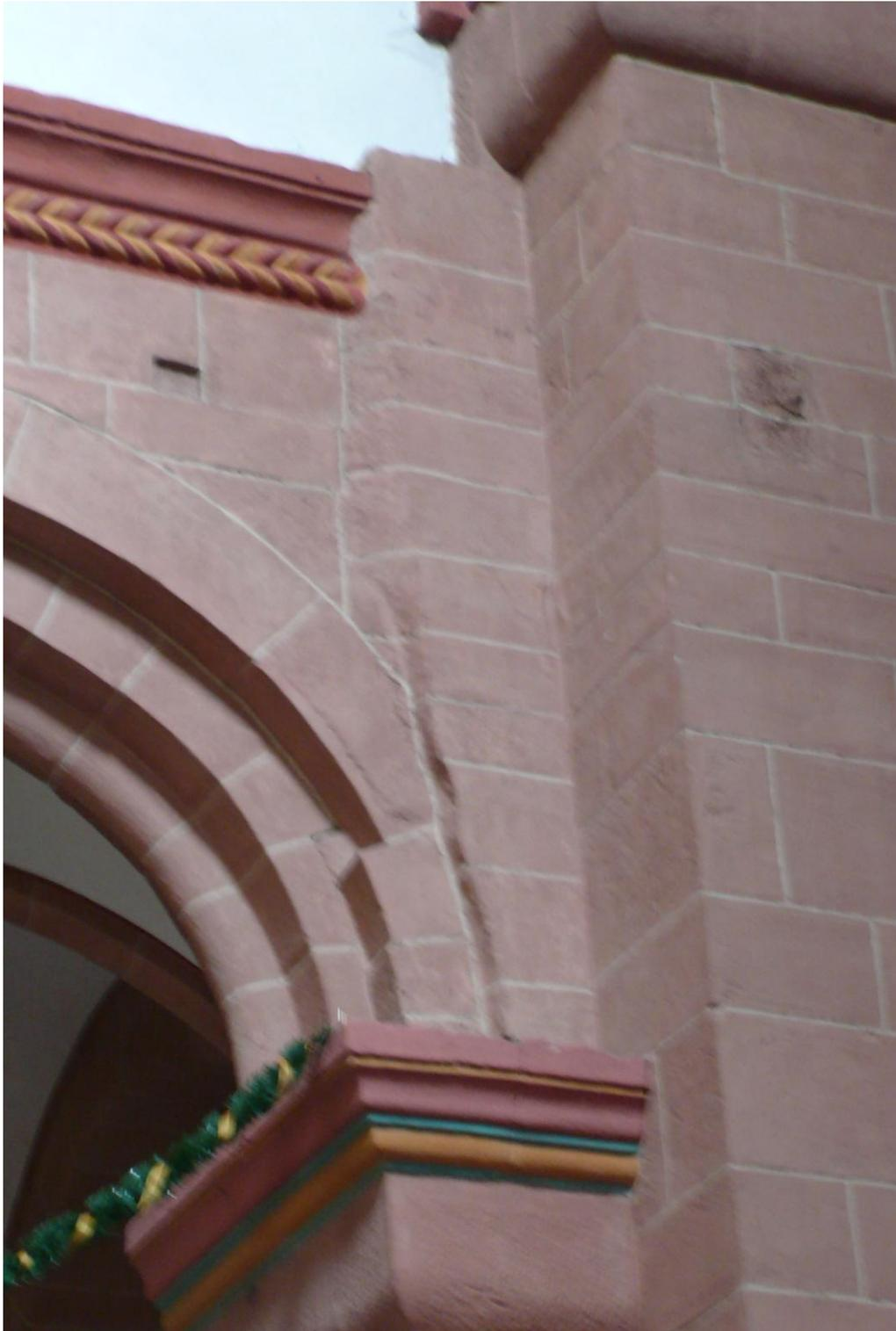
**Abb. 12:** Anschluss der Nordarkade an den nordwestlichen Vierungspfeiler. Vom Pfeiler ausgehend trifft eine deutlich stärkere Wand auf die filigranere Arkadenzone, was einen Planwechsel wahrscheinlich macht. Der nach Westen anschließende Freipfeiler ist nicht stark genug, um einen Turm zu tragen. Deswegen ist die Annahme der *chorus minor*-Türme unwahrscheinlich.
