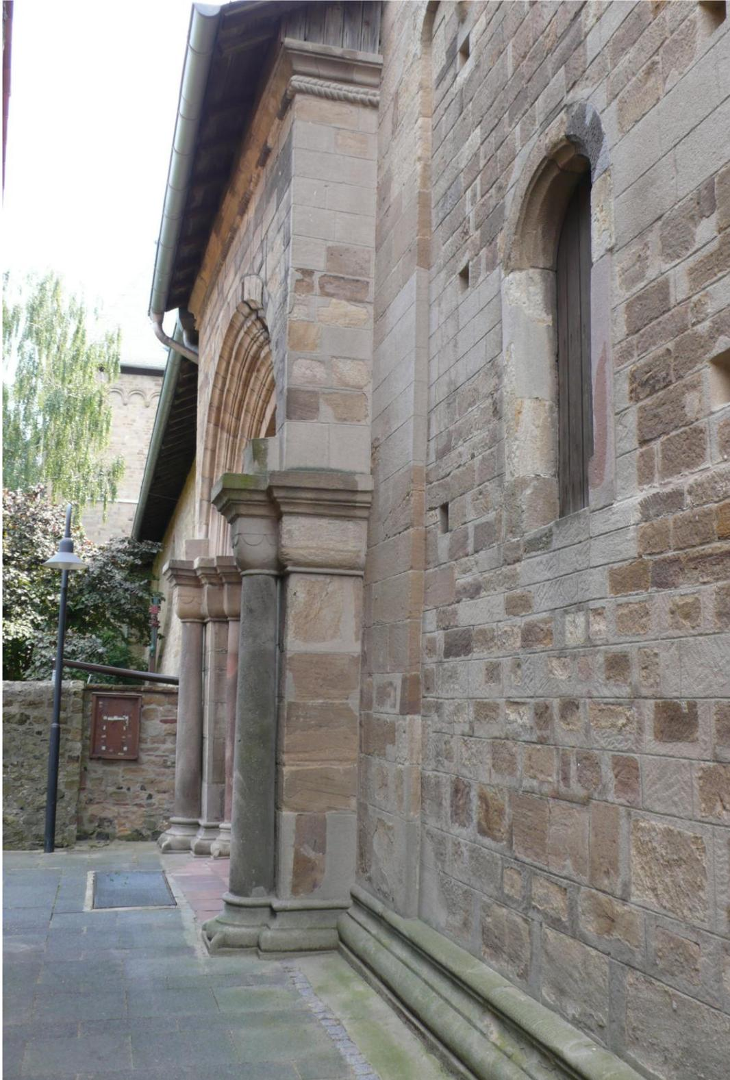
**Abb. 15:** Die Nordseite der Basilika von der Nordwestecke aus gesehen. Im Vordergrund die Wand des Nordturms. Darin in ca. 2,50 Meter Höhe die Tür in das ehemals direkt anschließende Nebengebäude. Im Bildmittelgrund das Risalit ähnliche Nordportal, dahinter das Nordseitenschiff und im Hintergrund das Nordquerschiff.
