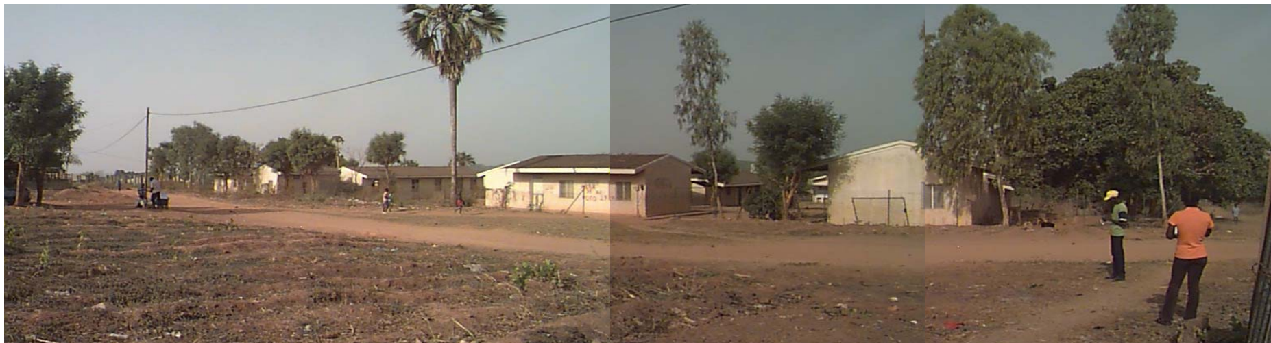
Escola secundária e via de acesso ao polivalente, à rádio, centro de Jovens, AD, assoc. de moradores
