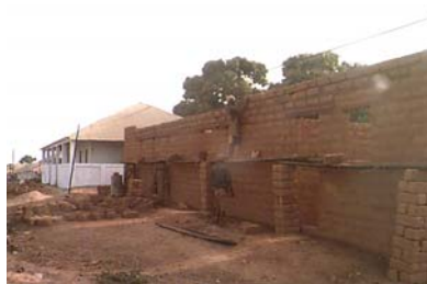
Construção de habitação
