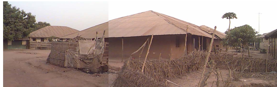
“Quartinho”-poço absorvente com latrina - Quelélé
