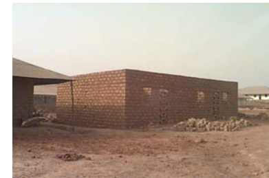
“Paredes e chão” construídos
