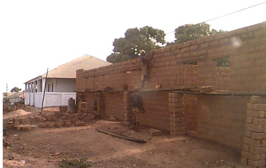
Construção de casa com blocos de adobe
