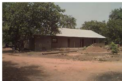
Habitação em fase final de construção
