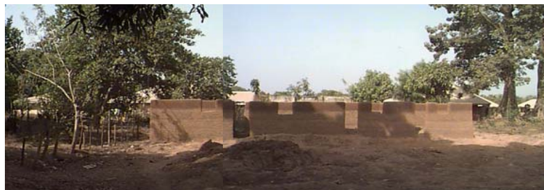
Construção de habitação
