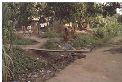
Vala destinada a águas pluviais cobertas de lixo
