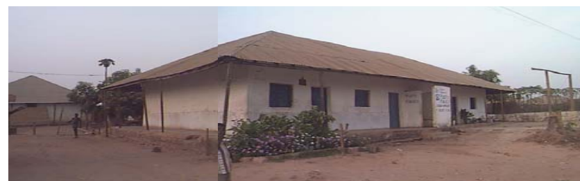
Construção de habitação finalizada
