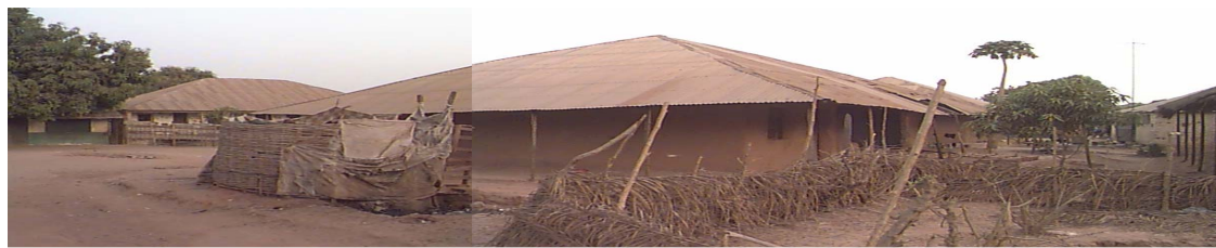
Poço absorvente com latrina no exterior da habitação
