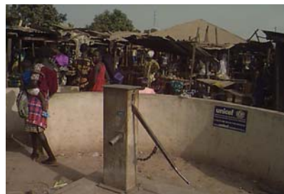
Bomba de água manual
