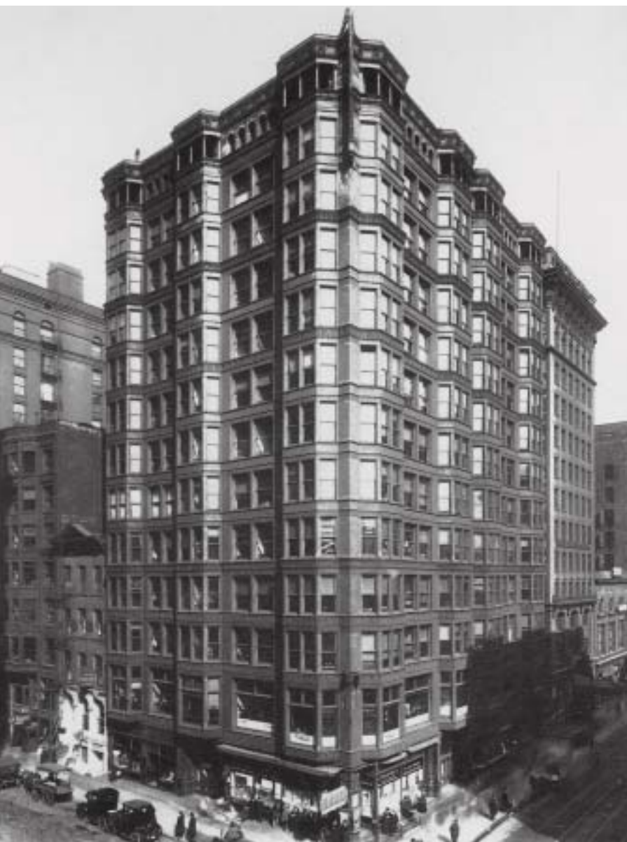
Die ersten Hochhäuser in Chicago – mehr Platz für Geschäfte und Büros: Die feuerfeste Ummantelung des Eisenskeletts sowie die Erfindung des Fahrstuhls trugen dazu bei, den Gebrauchswert des teuren innerstädtischen Bodens weiter zu steigern.
