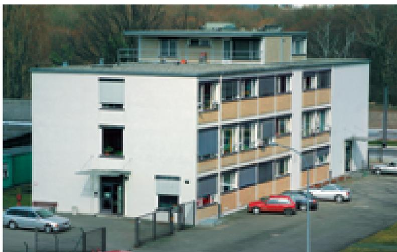
miteinander und bilden eine Art Klammer um die Campus-Fläche. Diese Gebäude sind, wie fast alle Kramerschen Entwürfe für die Frankfurter Universitätsinstitute, Betonskelettbauten. Dieses Betonskelettbauwerk hat den Vorteil, im Innern dispo- nible Grundrisse zu ermöglichen, weil das Raster sämtliche Trage- und Stützfunktionen des Baus übernimmt und die Wände von die-
