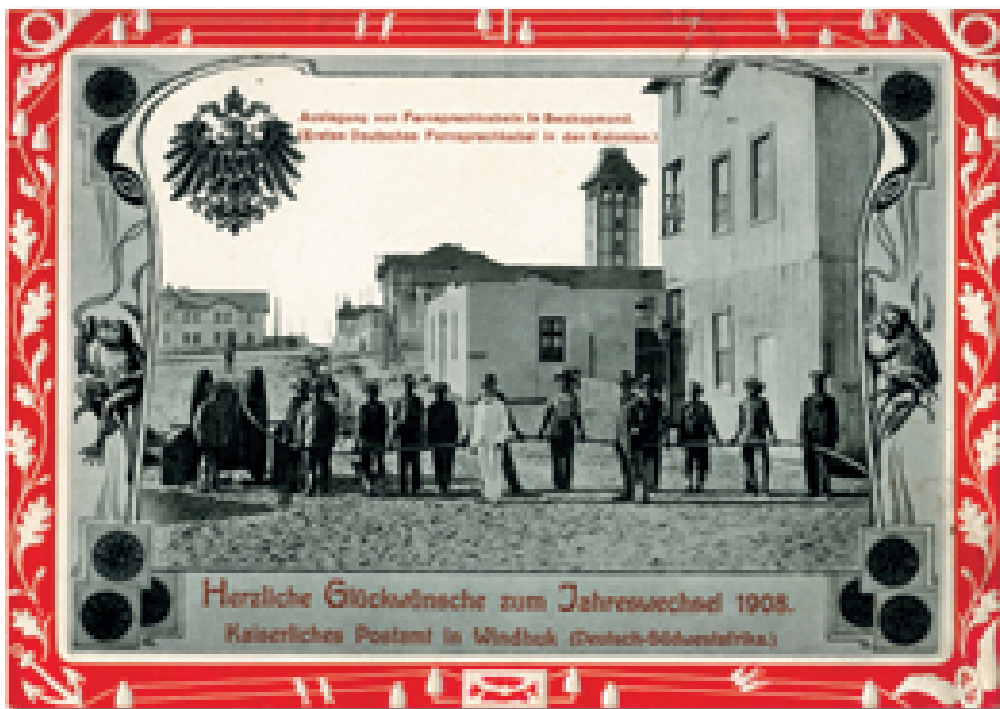
Das Kaiserliche Postamt in Windhoek um 1910 präsentiert sich stolz mit einer Neujahrspostkarte. Gezeigt wird das Auslegen eines Fernsprechkabels, das die Einführung der europäischen Zivilisation in der Kolonie dokumentiert.
