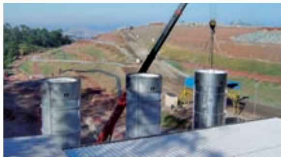
Mülldeponie in São João, Brasilien: Bei der Vergärung des Mülls entsteht Methan gas, das zum Schutz der Atmosphäre eingefangen wird. Diese Anlage wurde teilweise über Emissionszertifikate finanziert.
