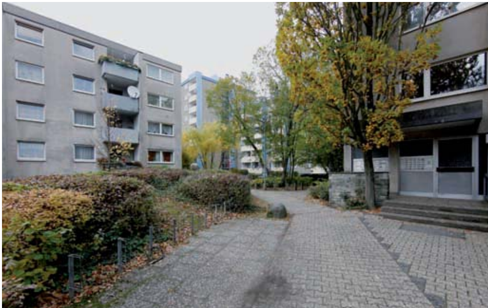
In der Mitte der Moderne – was in den 1970er Jahre als zeitgemäß galt, zählt heute zu den Sanierungsfällen. Siedlungen wie das nach dem früheren Bundespräsidenten Heinrich Lübke benannte Wohngebiet entlang der Ludwig-Landmann-Straße in Praunheim sollen demnächst umgebaut werden – mit dem Anspruch, ein Modellprojekt für energieeffiziente Sanierungen schaffen zu können.
