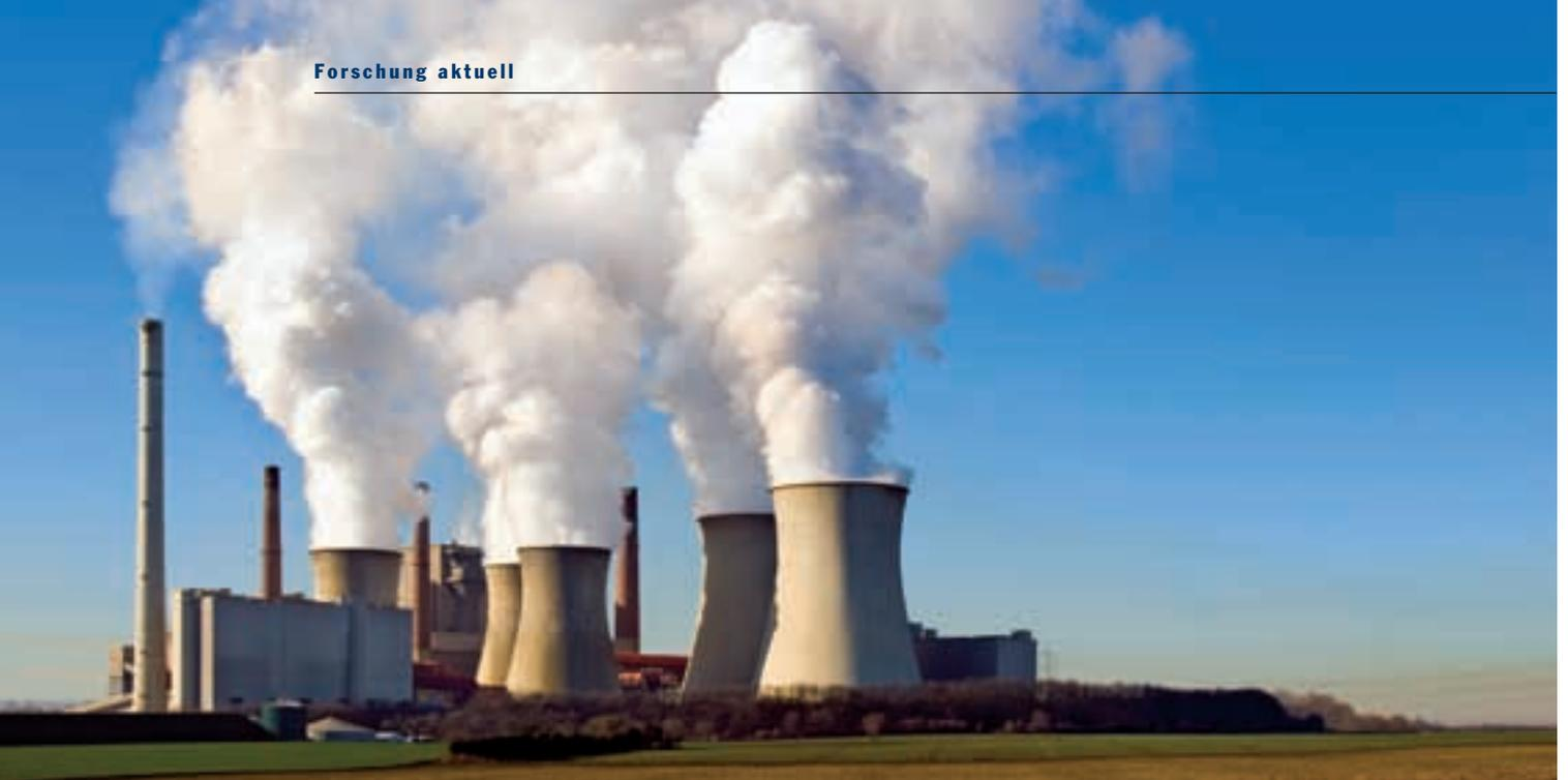
▣ Kohlekraftwerke emittieren außer Wasserdampf und verschiedenartigen Partikeln auch das unsichtbare Gas Kohlendioxid (CO<sub>2</sub>). Steigen derartige Gase in ihren atmosphärischen Konzentrationen an, kommt es zu Erwärmungen der unteren Atmosphäre (Verstärkung des Treibhauseffektes). Auch andere fossile Energieträger tragen dazu bei (Öl, Gas, einschließlich Verkehr). Unser Bild zeigt ein Braunkohlekraftwerk im Rheinland.
