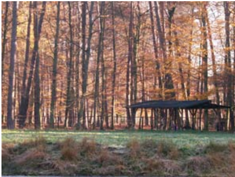
Abb. 34 Holzunterstand am südlichen Gehegerand (Alte Fasanerie) im Vordergrund ist ein Teil des Grabens zu erkennen
