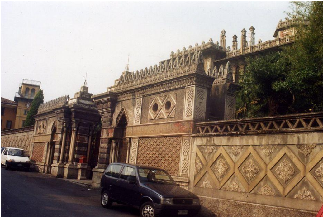
Abb. 136: Umfassungsmauer der Villa Gheza. Breno. 1929–35
