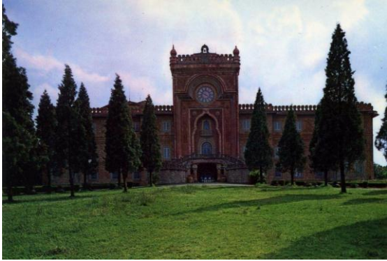
Abb. 2.: Ostfassade des Castello Sarmezzano. Regello. 1841–70
