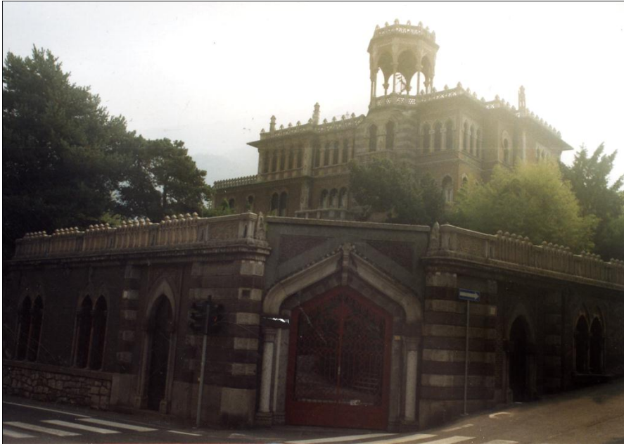
Abb. 135: Außenansicht der Villa Gheza. Breno. 1929–35
