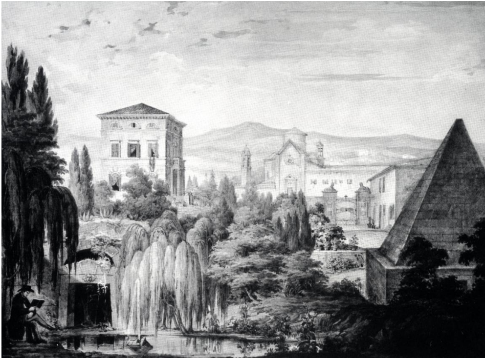
Abb. 84: Gesamtansicht des Gartens der Villa Il Pavone aus westlicher Richtung. Zeichnung: Alessandro Maffei, 1835
