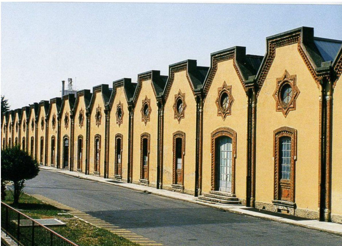
Abb. 73: Erweiterungsbauten der Fabrikationssäle des Villaggio Crespi d'Adda
