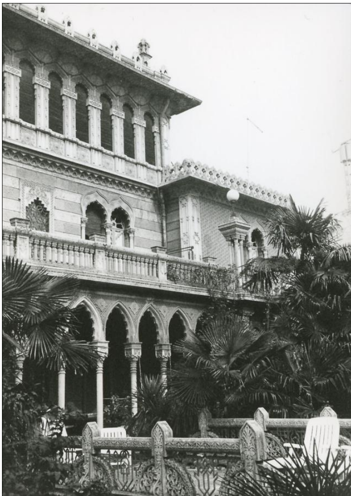
Abb. 137: Östliche Loggia der Villa Gheza. Breno. 1929–35
