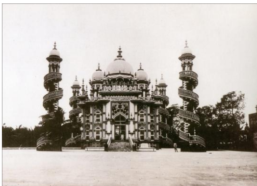
Abb. 113: Mahabat Maqbara. Mausoleum der Nawabs in Junagadh/ Gujarat, Indien. Begonnen 1878 von Mahabat Kanji, fertiggestellt 1892 von Bahadur Kanji
