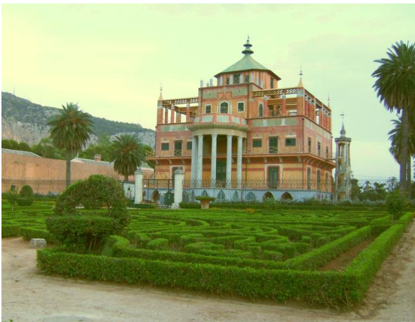
Abb. 1: Westliche Fassade der Palazzina Cinese. Palermo. 1790–1815
