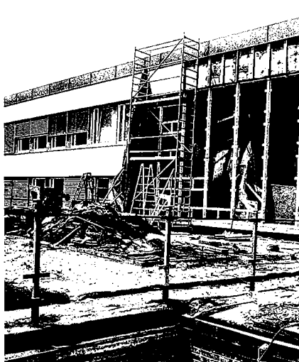
Blick aus dem Labor durchs Fenster während der Bauphase
