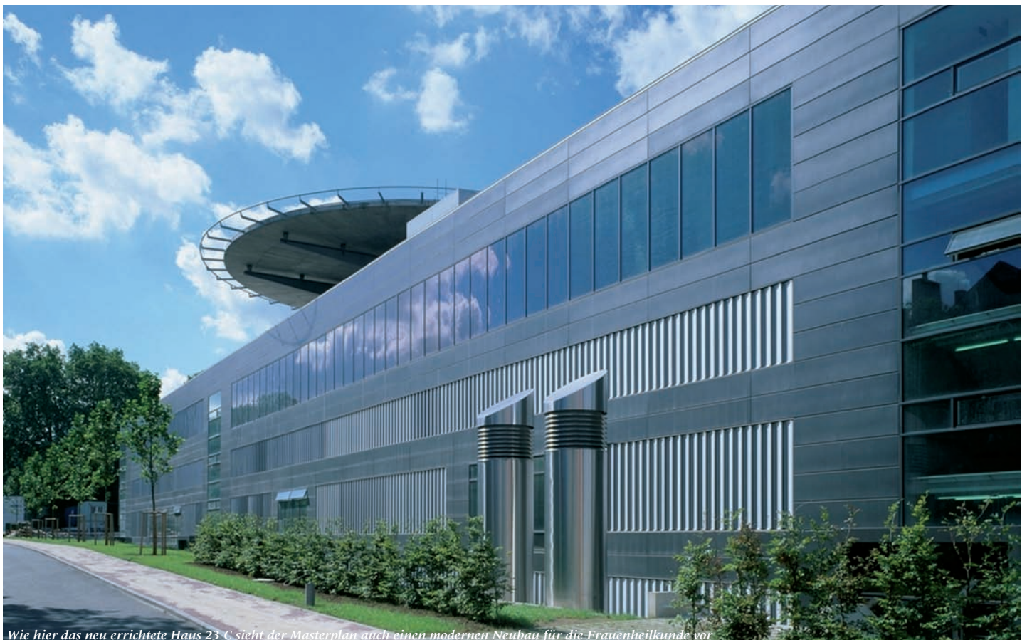
Wie hier das neu errichtete Haus 23 C sieht der Masterplan auch einen modernen Neubau für die Frauenheilkunde vor
