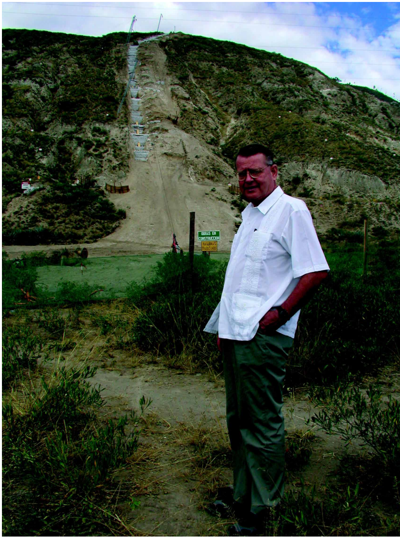
Weltbank-Umweltexperte Dr. Robert Goodland besichtigt die Pipeline-Baustelle
