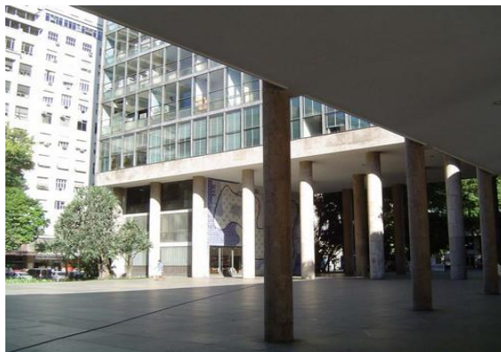
Fig. 5 – Foto a nível do observador. Pilotis que geram a permeabilidade do quarteirão. 7
