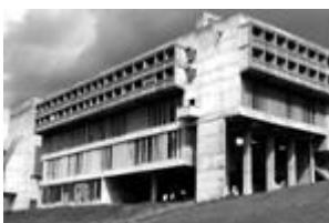
Figura 7: Convento La Tourette Eveux-sur-l’Arbresle (1957-1960) 14
