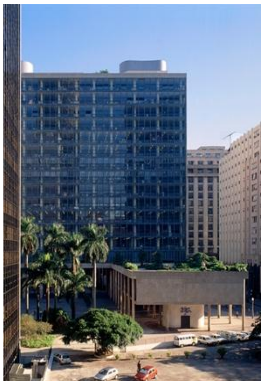
Fig. 8 – A independência estrutural possibilitando a abertura de maiores rasgos ou então o uso de grandes panos de vidro. 10
