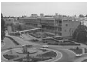
Figura 9: Centro Cívico de Santa Rosa - La Pampa, vista geral em 2005 23
