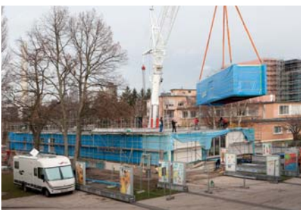
Anlieferung und Aufeinanderstapeln der ersten Module
