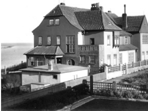
Institutsgebäude der Vogelwarte Helgoland an der Ostklippe bis zur Zerstörung 1943. Foto: Archiv IFV
