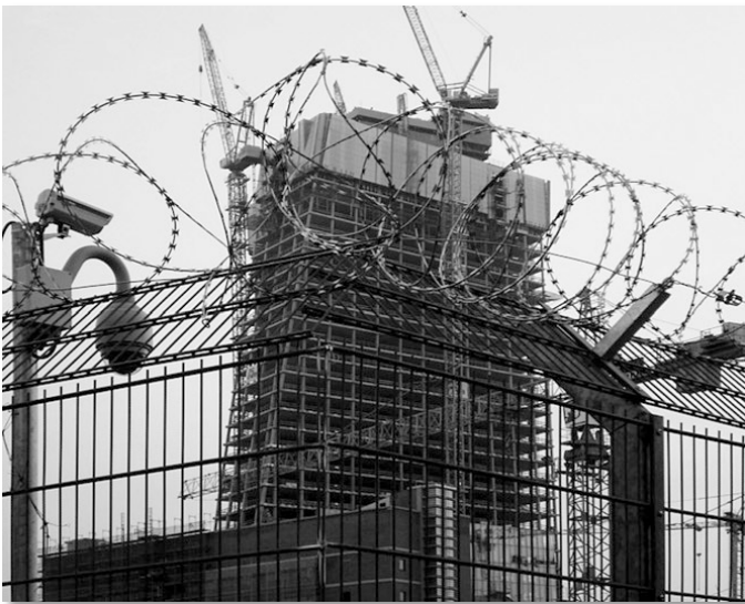
Abb. 1: Absicherung der Baustelle der Europäischen Zentralbank im Frankfurter Ostend
