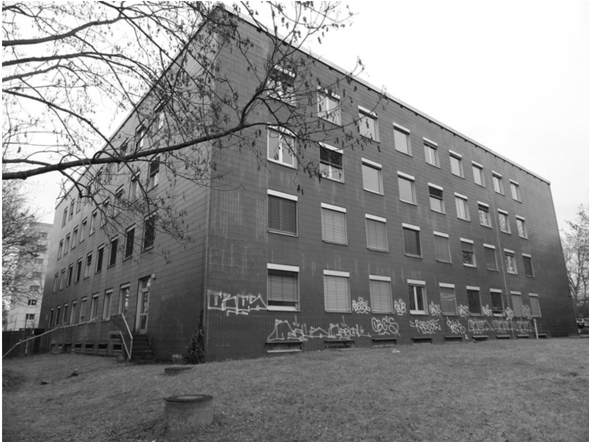
Abbildung 2: Ehemaliges Landesarbeitsgericht und Frankfurter Arbeitsgericht, Adickesallee 36 (Quelle: Netzwerk Frankfurt für gemeinschaftliches Wohnen e.V.)
