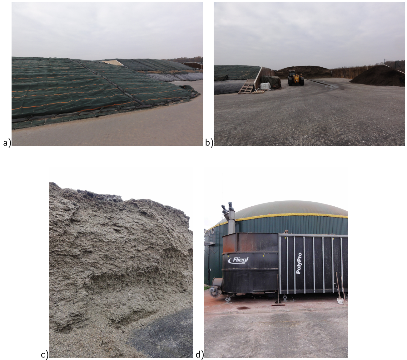
Abbildung 3.4.1: Bilder der Biogasanlage Semd (Teil 1): a) Silo b) Teleskoplader im Silo c) Silage im Silo d) Feststoffdosierer mit Förderschnecke am Fermenter (Quelle: HSE AG).
