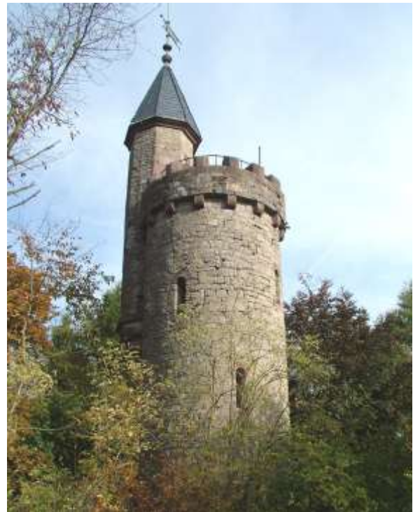
Abb. 24: Bismarckturm, Ansicht von Westen (Foto: Autor).
