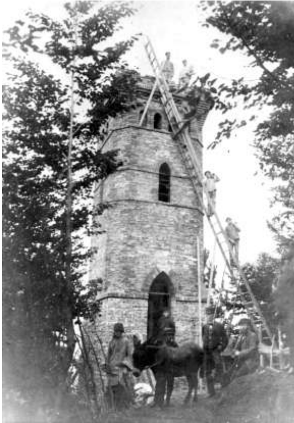
Abb. 23: Fertigstellung des Rodeneckturms 1883 (Foto: Sammlung HENZE).
