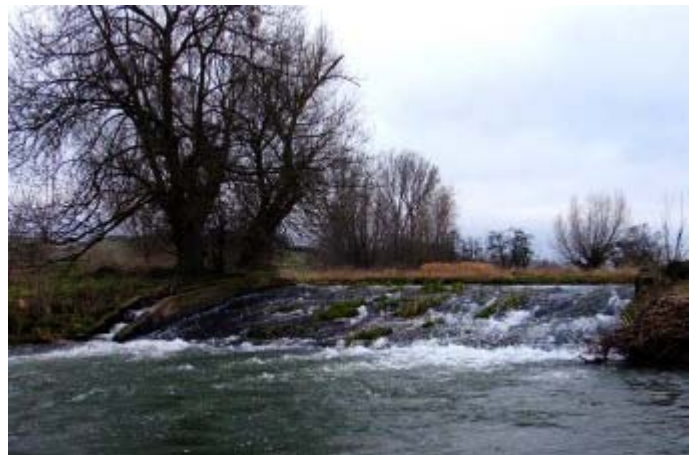
Abb. 4: Die „alten Fischtreppe“ in Beller und Erkeln ermöglichen zwar schwimmstarken Fischarten insbesondere bei hohem Wassergang den Aufstieg. Schwimmschwache Arten sowie Arten des Makrozoobenthos haben unter diesen Bedingungen allerdings keine Chance aufzusteigen.
