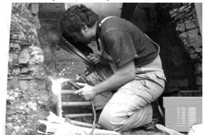
Abb. 12: Auch Teil der Aufgaben der praktischen Landschaftspflege: Uli WYCISK schweißt am 13.09.2007 Gitterstäbe vor den Stollen am Bielenberg, um unbefugtes Betreten dieses Fledermauslebensraums zu unterbinden (Foto: Diego KRÄMER).
