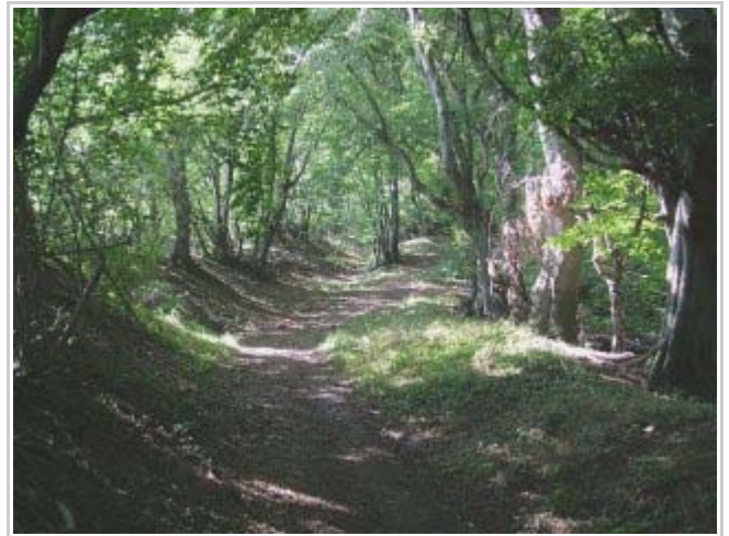
Abb. 9: Doppelte Wall-Graben-Anlage der Landwehr unterhalb der Brunsburg. (Foto M. Koch; Sept. 2004).
