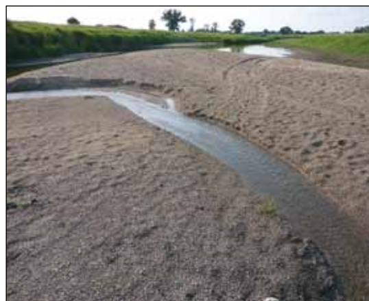
Abb. 10: Angeschlossene alte Flutmulde, teilweise mit Sand und Kiessediment aufgefüllt. Foto: R. Diebel (2010).
