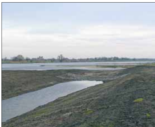
Abb. 3: Einlauf kurz nach Fertigstellung. Foto: R. Diebel (2006).
