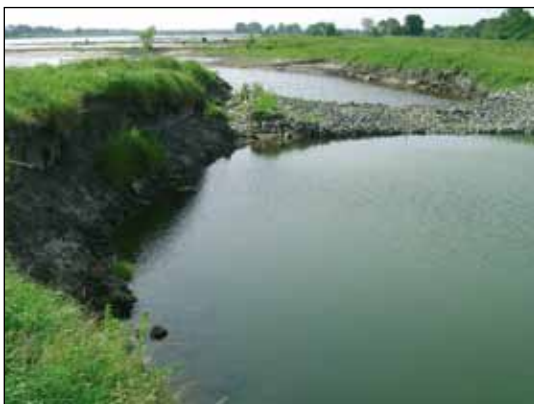
Abb. 7: Steilwand zur Elbe hin mit Umlauf tendenz an der Schwelle. Foto: R. Diebel (2008).
