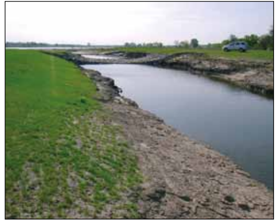
Abb. 6: Einlauf nach einem Jahr mit normalem Abfluss der Elbe. Foto: R. Diebel (2007).
