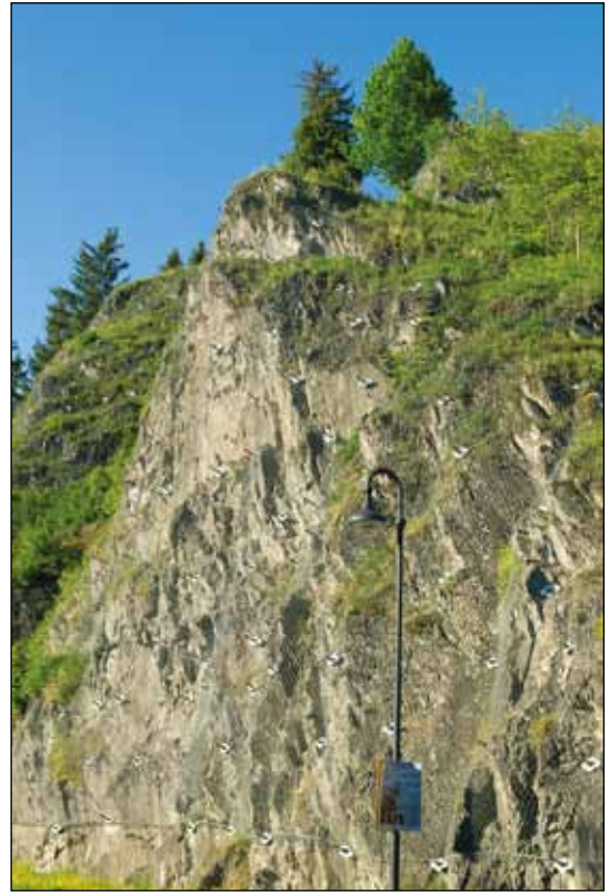
Abb. 5: Mittels Schutznetz gesicherter Felsen an einer Straße. Foto: G. Bürger.
