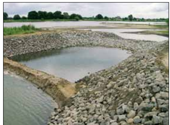
Abb. 8: Fertige neue Einlaufschwelle mit Tosbecken zum Energieabbau. Foto: A. Berbig (2008).
