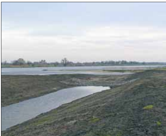
Abb. 3: Einlauf kurz nach Fertigstellung. Foto: R. Diebel (2006).
