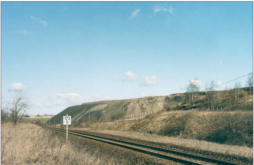
Abb. 42: Flachhalde des Niewandt-Schachtes, Blick von der Bahnlinie Siersleben-Hettstedt nach Nord-osten, 13.3.2003.
