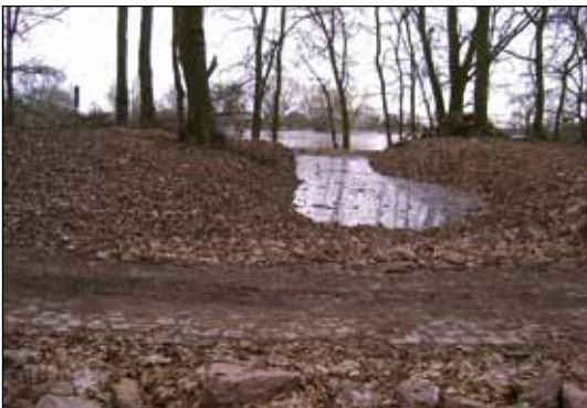
Abb. 5: Oberstromiger Anschluss einer Flutrinne an die Elbe durch Absenkung der Uferrehne einschließlich eines Wanderweges bei steigendem Abfluss der Elbe im März 2006. Foto: U. Patzak.
