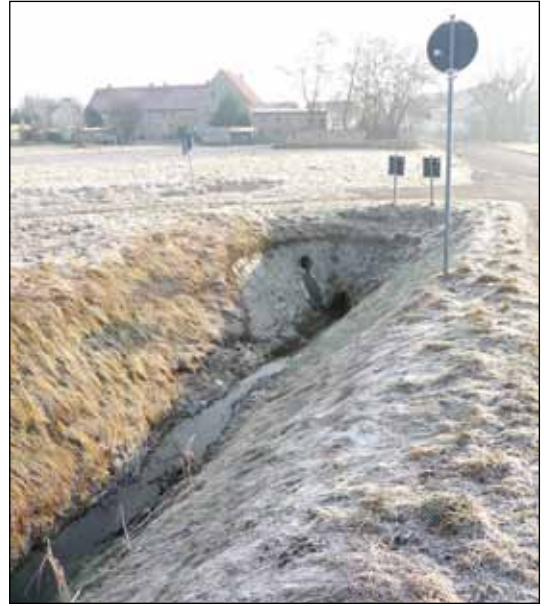
Abb. 3: Einmündung des Auslaufrohres des Dorfteiches in das zur Reide führende Grabensystem. Foto: W. Wendt.
