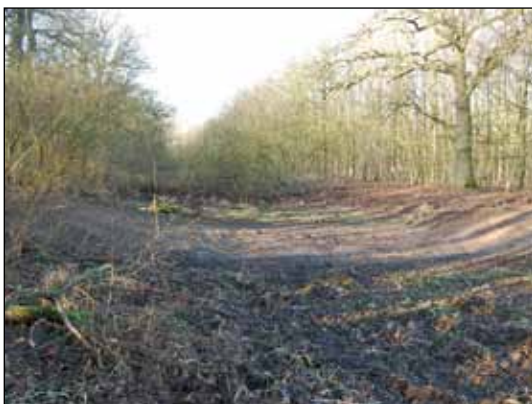
Abb. 9: Beseitigung eines Wegedammes in einer Flutrinne im Hartholzauenwald im Januar 2007. Foto: U. Patzak.
