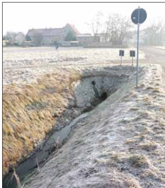
Abb. 3: Einmündung des Auslaufrohres des Dorfteiches in das zur Reide führende Grabensystem. Foto: W. Wendt.
