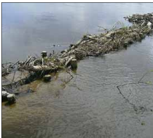
Abb. 7: Bau einer ökologischen Buhne als sogenannte „Totholzstufe“ bei Beuster (Elbe-km 450,7 - linke Elbeseite). Foto: A. Anlauf.
