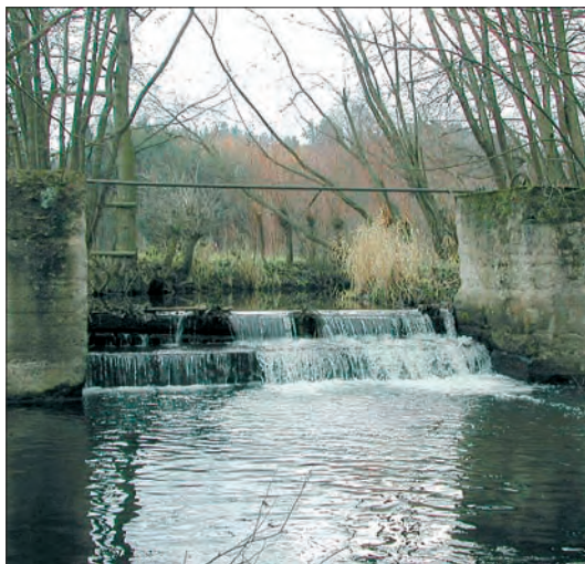
Abb. 1: Wehr Wippra / Wipper. Die ökologische Durchgängigkeit für Fische und Makrozoobenthos ist nicht gegeben. Foto: C. BRÄUNIG.
