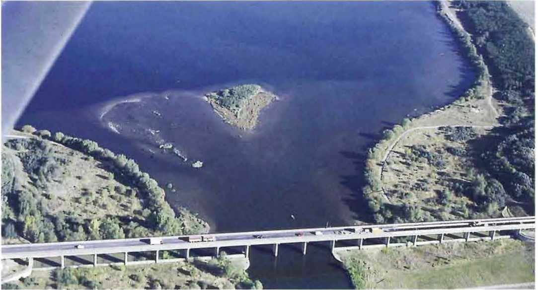
Abb. 2: Auslaufbauwerk Muldestausee als bedeutendste ökologische Barriere im Fluß (Foto: G. Puhmann)
