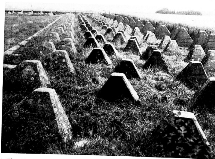
Abb. 1: Übersichtsfoto vom Panzersperren-Gürtel zwischen Vetschau und Horbach. Die Strukturträger mit dem Mauerrand (links) und der hohen Höckerreihe (rechts) werden durch die Weidenutzung gut erkennbar (August 1986).
