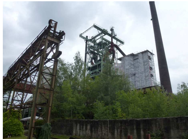
Abb. 2: Industrieruinen auf dem Gelände (A. HÖGGEMEIER).
