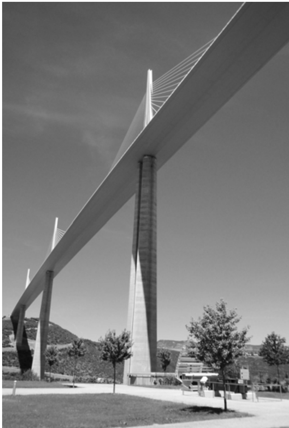
Abb. 61 Viaduc de Millau, Foto Roland Wüest
