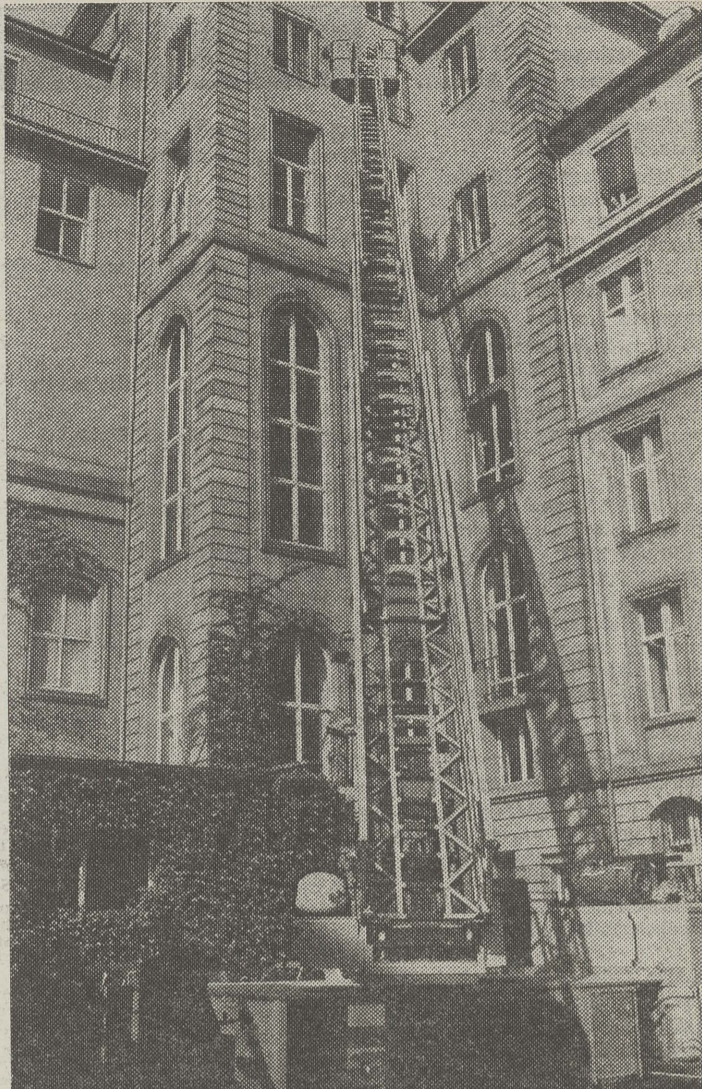
Bei einer der üblichen Brandschauen wurde auch die „lange Leiter“ der Feuerwehr ausgefahren. Die Benutzer des Hauptgebäudes können — wie das Bild zeigt — im Notfall auch aus dem obersten Stock über die Leiter gerettet werden.
