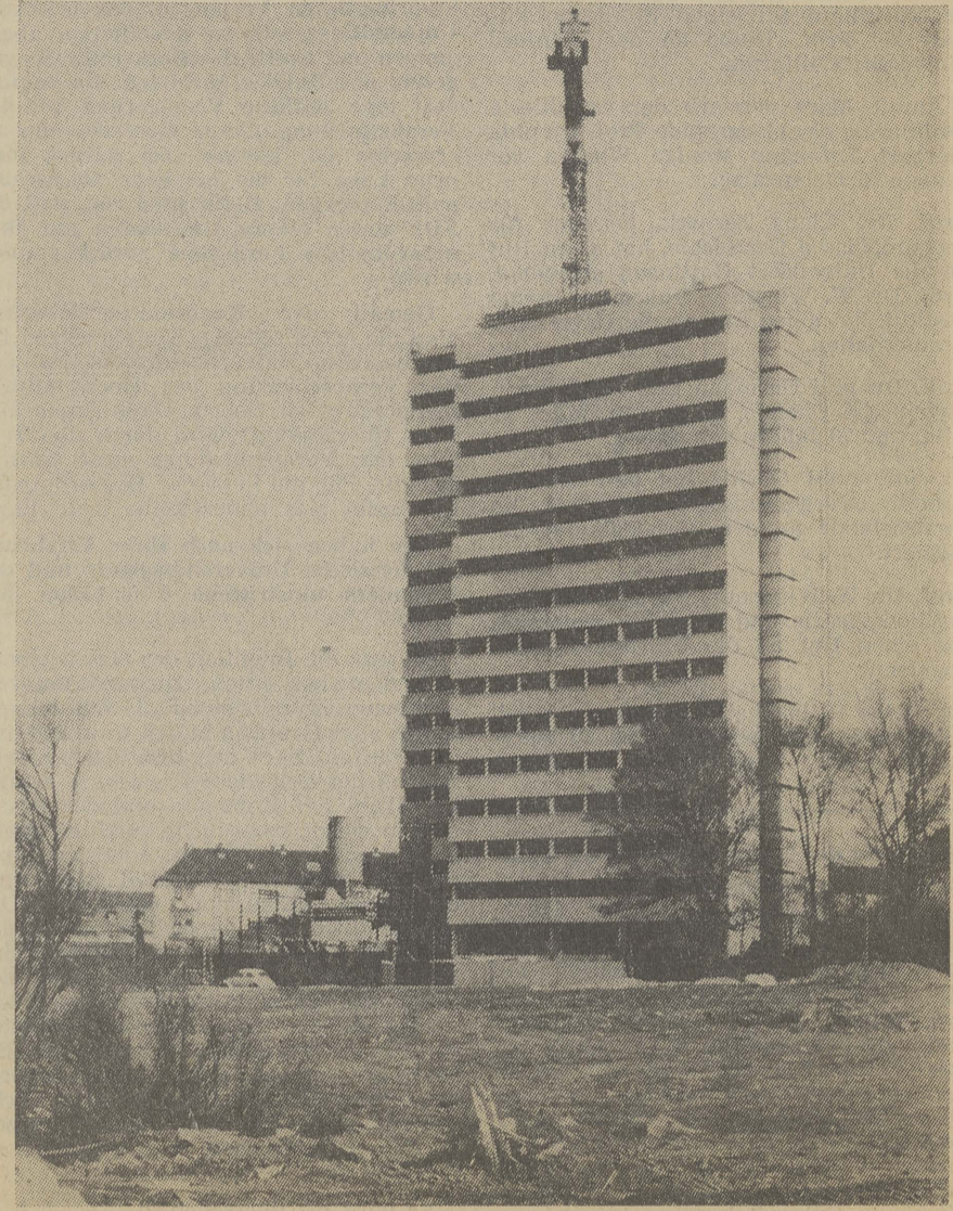
Das im Rohbau fertiggestellte Wohnheim an der Ginnheimer Landstraße wird Anfang nächsten Jahres bezogen werden können. Dann werden dort 333 Einbettzimmer, 14 2-Zimmer-Appartements und 15 3-Zimmer-Appartements zur Verfügung stehen. Die Gesamtkosten werden ungefähr 10 Millionen DM betragen.
