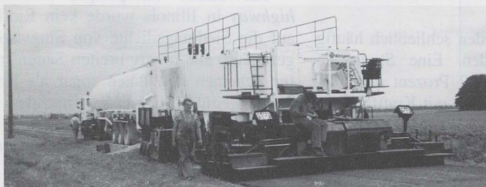
Fahrbahninstandsetzung mit Arbeitsbreiten von 1 m bis 4,5 m
