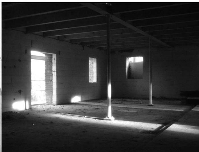
Blick in den vorderen Teil neuen Gemeindesaal im Erdgeschoss der Lohmühle. Die Brandspuren sind beseitigt; die Holzbalken wurden durch Stahlträger ersetzt und die Decke neu eingezogen. (Foto: JG Bad Segeberg)
